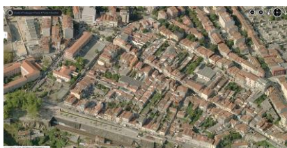
3. Vista aérea das ilhas na Rua de S. Vítor
