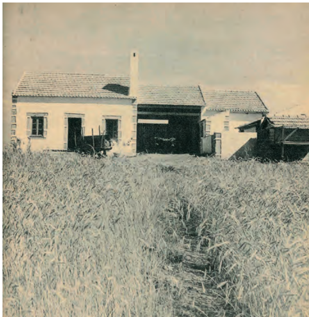
FIG. 5 Casal na Colónia Agrícola de Martim Rei, Sabugal [c. 1944] (agente técnico de construção Dâmaso Constantino para a JCI, 1937) [SNI, 1944]. Biblioteca do GPP/MAFDR/MMar
