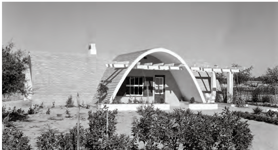
FIG. 20 Casa para Professora ou Padre em Santo Isidro de Pegões, Colónia Agrícola de Pegões, Montijo [c. 1954] (arquiteto Eugénio Corrêa para a JCI, 1951). FCG/BAA. Estúdio Novais
