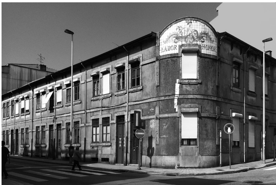
Fig. 1 - Bairro “Labor Honor” construído em 1928. Fotografia do autor, 2012.
