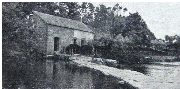
Fig. 22 – Azenha da Barca e respectivas rodas verticais; (Cunha, J.; 1938).
