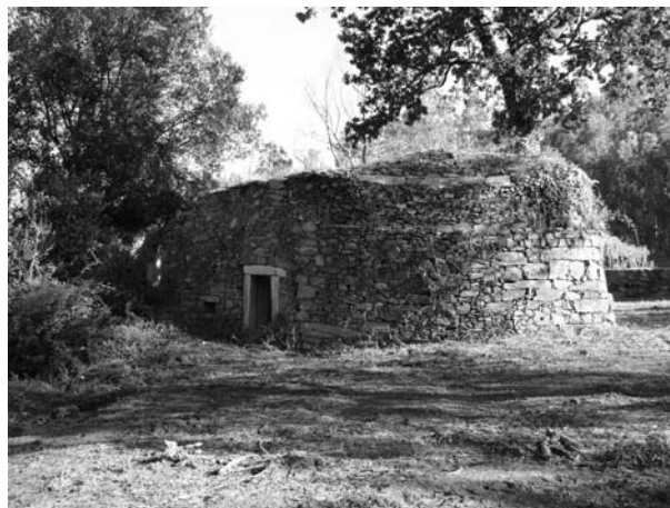
Fig. 17 – Azenha do Zé da Carolina, (estado actual). Quebramar maciço e porta de acesso ao Açude; (Matos, B.; 2010).
