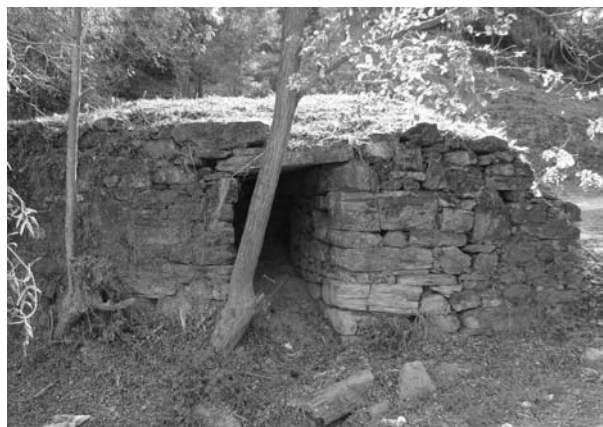
Fig. 16 – Azenha da Esprela, (estado actual). Porta de acesso ao Açude; (Matos, B.; 2010).
