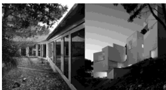
3. Álvaro Siza. 1964.1968 | Casa Alves Costa; 2002.2007 | Casa Maiorca
