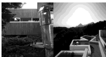
6. Relação com o Lugar. Marcel Breuer. 1949.51 | Wolfson House; Álvaro Siza. 2002.2008 | Casa de Maiorca
