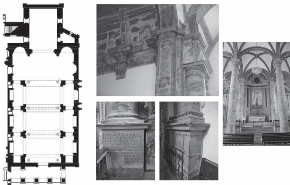
Fig. 5. Da esquerda para a direita: planta da igreja de S. Gonçalo de Amarante, em que se assinalou a localização das colunas da igreja-salão; coluna do cruzeiro, sobrepujada por mísula e estátua que oculta o arranque da antiga nervura da abóbada de cruzaria; plintos das colunas e pilastras do cruzeiro e da nave e interior da igreja da Misericórdia de Santarém.
