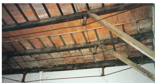
a) Pavimento de vigas de madeira reforçado em 1920
