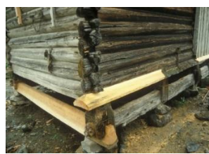
b) Reparação da madeira, Tokke, Noruega [35].
