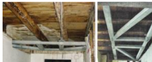
b) Reforço da capacidade de suporte com uma estrutura metálica. [38]
