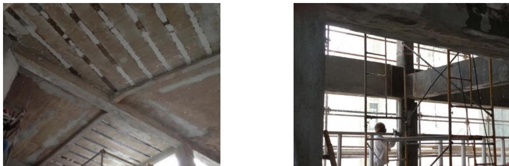
Figura 2.35 - Reforço estrutural do edifício Associação Recreativa e Cultural das carpintarias de São Lázaro com laminados de carbono (S&P Clever Reinforcement Ibérica, 2016 [49]).
