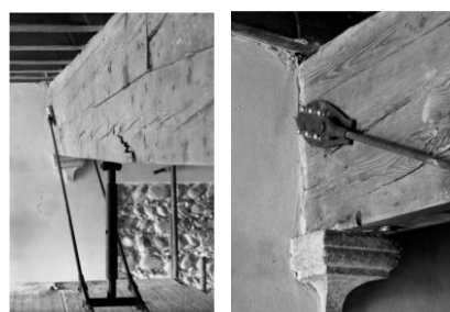
b) Viga de madeira reforçada, atualmente.
