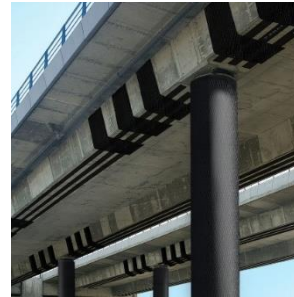
b) Aspeto geral de reforços à flexão, ao corte e ao confinamento com mantas de CFRP.
