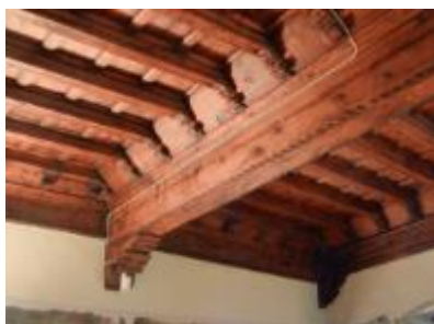
a) Teto de uma laje de madeira e viga
