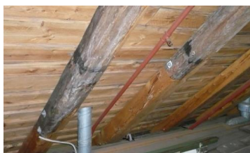
a) Substituir partes de vigas em estado de rotura, Bryggen, Bergen, Norway, 2008 [25].
