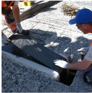
a) Aplicação de manta de CFRP
