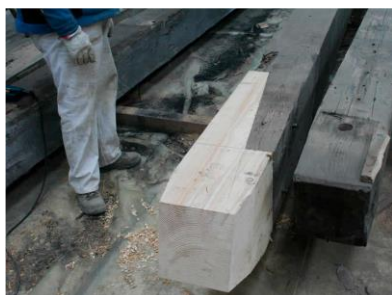
a) Prótese de madeira reforçada com aço inoxidável [25]
