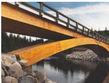
a) Ponte de Quebec, Canadá [30]
