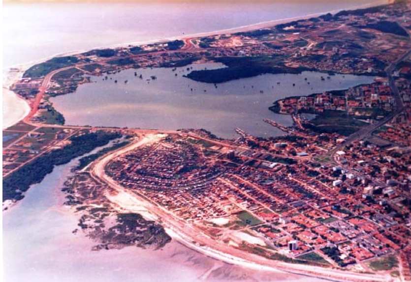
Figura 4: Visão aérea das obras de Saneamento da Lagoa da Jansen
