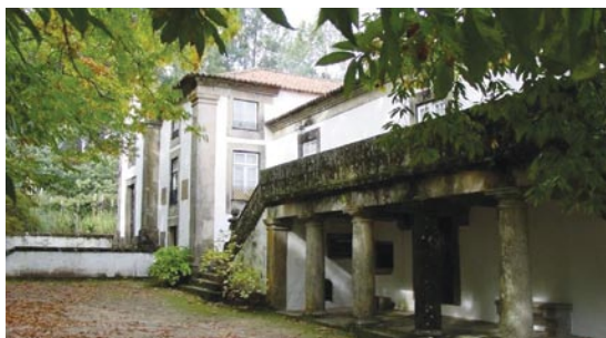
Fig. 9 – Casa do Outeiro – Ponte de Lima.
