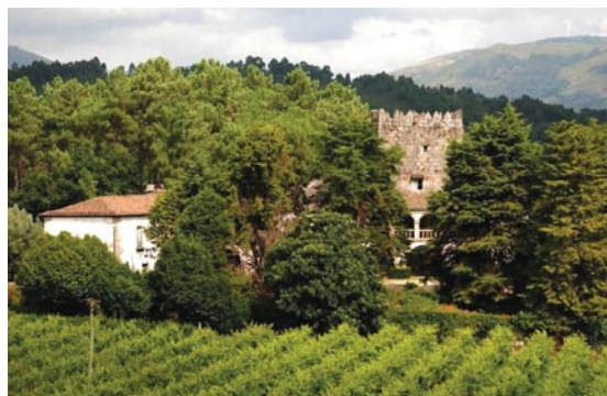
Fig. 5 – Torre e Casa de Aguiã – Arcos de Valdevez
