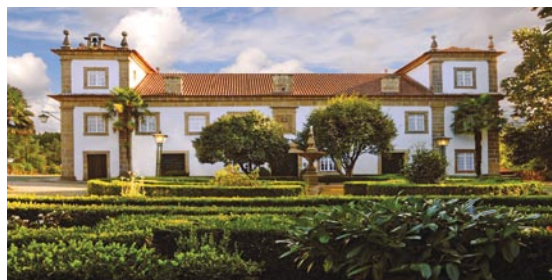
Fig. 4 – Solar de Serrada – Monção.
