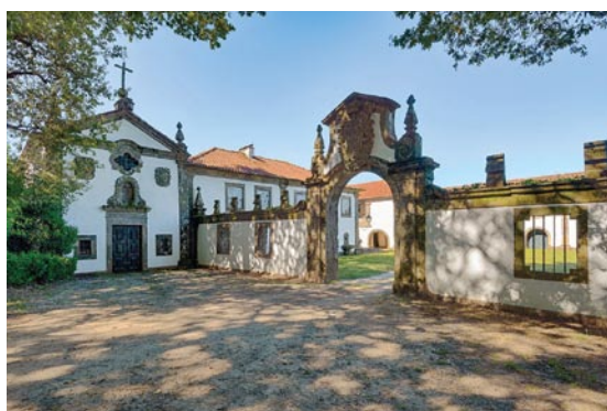
Fig. 6 – Paço de Lanheses – Ponte de Lima.
