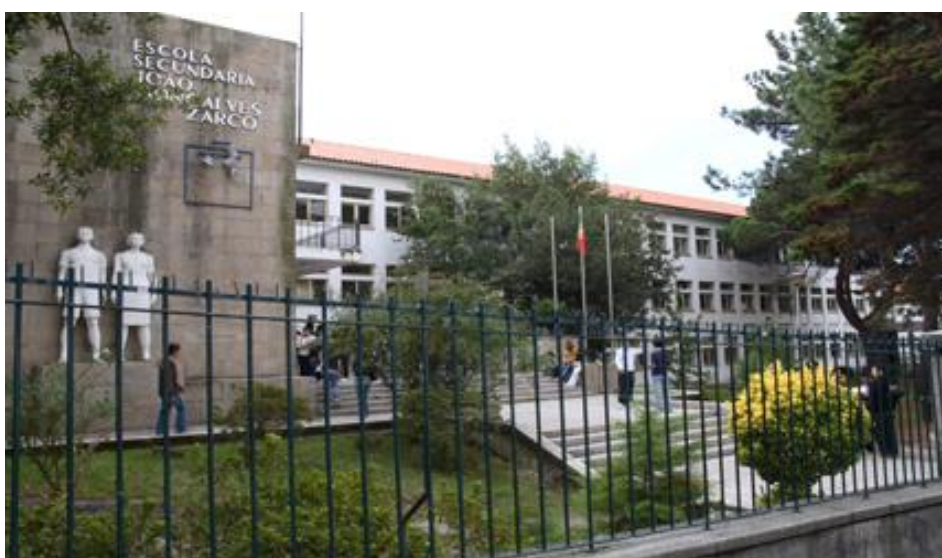
Figura 2 – Escola Secundária João Gonçalves Zarco
