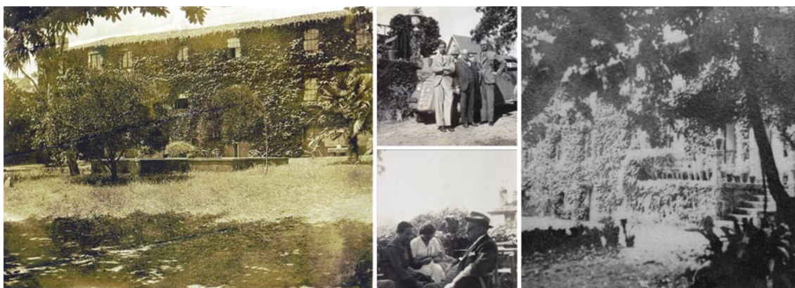
Fig. 16 – Fachada sul coberta de vinha virgem e registos da vivência do patamar voltado para o jardim-arquivo.
