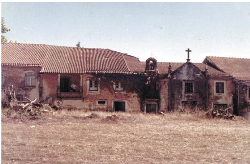
Fig. 11 – Fachada norte – alpendre e capela.
