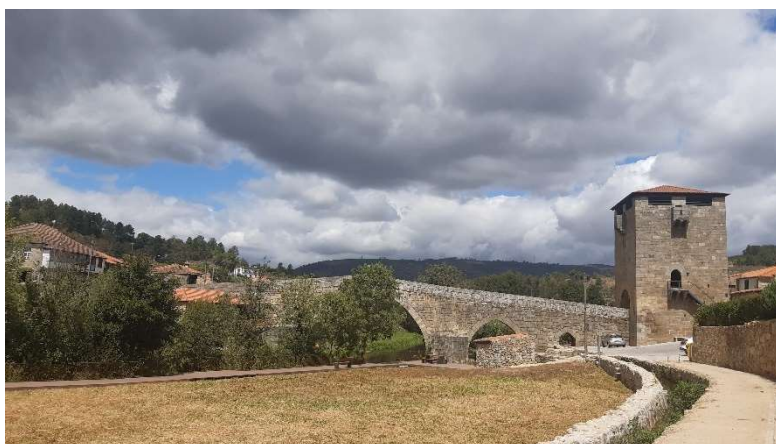
Imagem 53 – Envolvência da Ponte fortificada (zona verde e percursos pedonais) Fonte: autor
