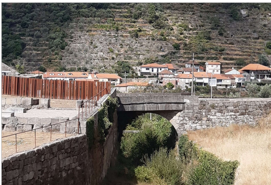
Imagem 50 – Ponte anexa ao complexo monástico, descaracterizada após intervenção da autarquia local
