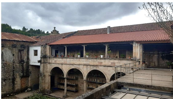
Imagem 51 – Parte superior do Claustro da Colação, residência do pároco de Salzedas Fonte: autor
