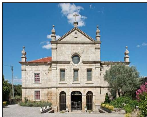
Imagem 17 – Fachada da igreja do Convento de Ferreirim Fonte: Pedro Martins /DRCN
