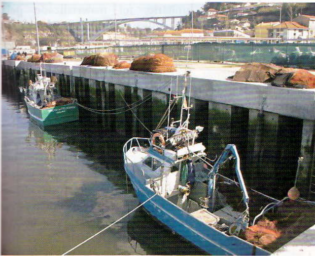
Figura 3. Cais de acostagem da Afurada em blocos NOREF.
