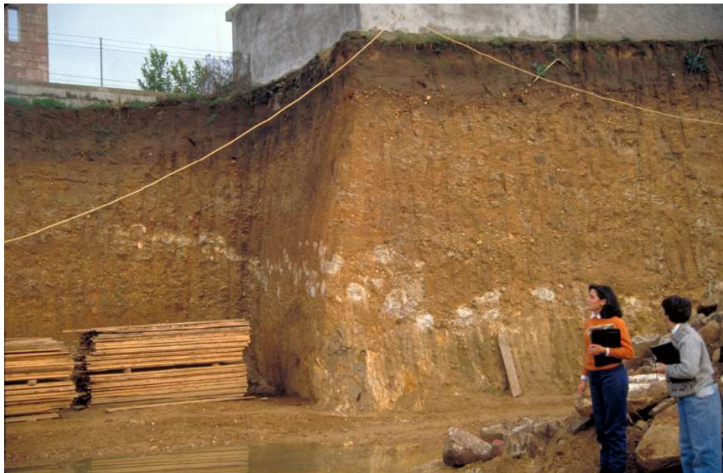
Figura 12 - Corte da base do depósito da fase II. Notar o carácter irregular da base onde coexistem blocos de granito podre e blocos de depósito da fase I. Cota= cerca de 80m.
