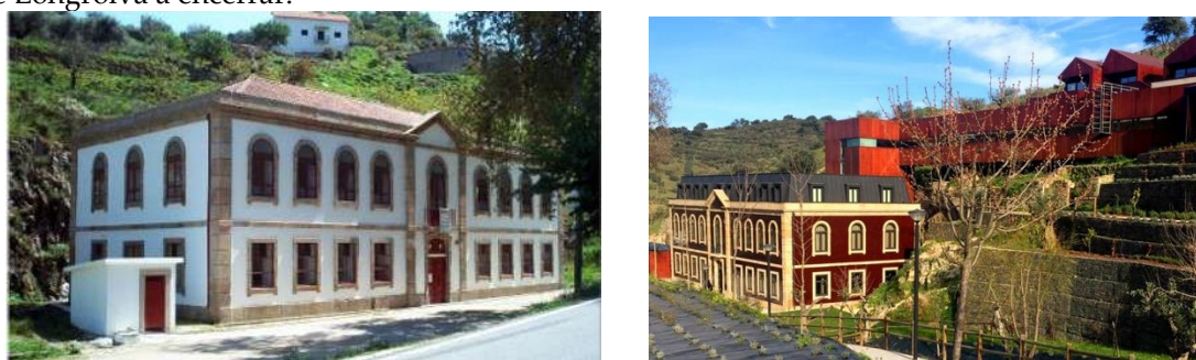
Figura 3 – O antigo edifício das Termas (1999) e o Hotel Rural de Longroiva e as Termas. Fonte: Hotel Rural Longroiva
