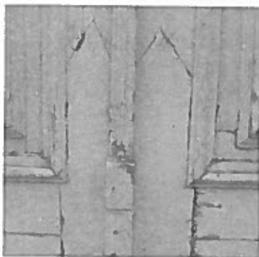
Figura 7. Substituição parcial das couceiras de uma porta.
