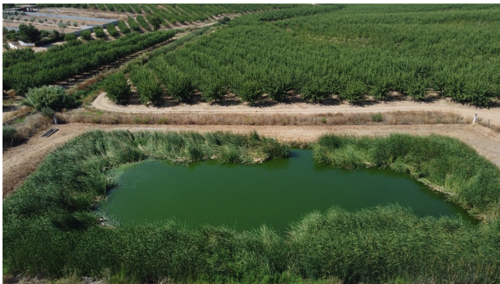
Figura 17 - Vista da Lagoa de Maturação Sul (Hidrofunção – Consultores de Engenharia, Lda).
