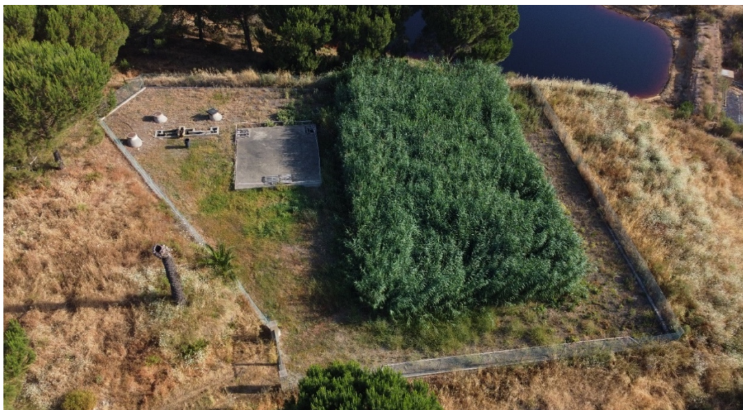
Figura 10 - Vista Geral da ETAR de Lousal Norte (Hidrofunção – Consultores de Engenharia, Lda).
