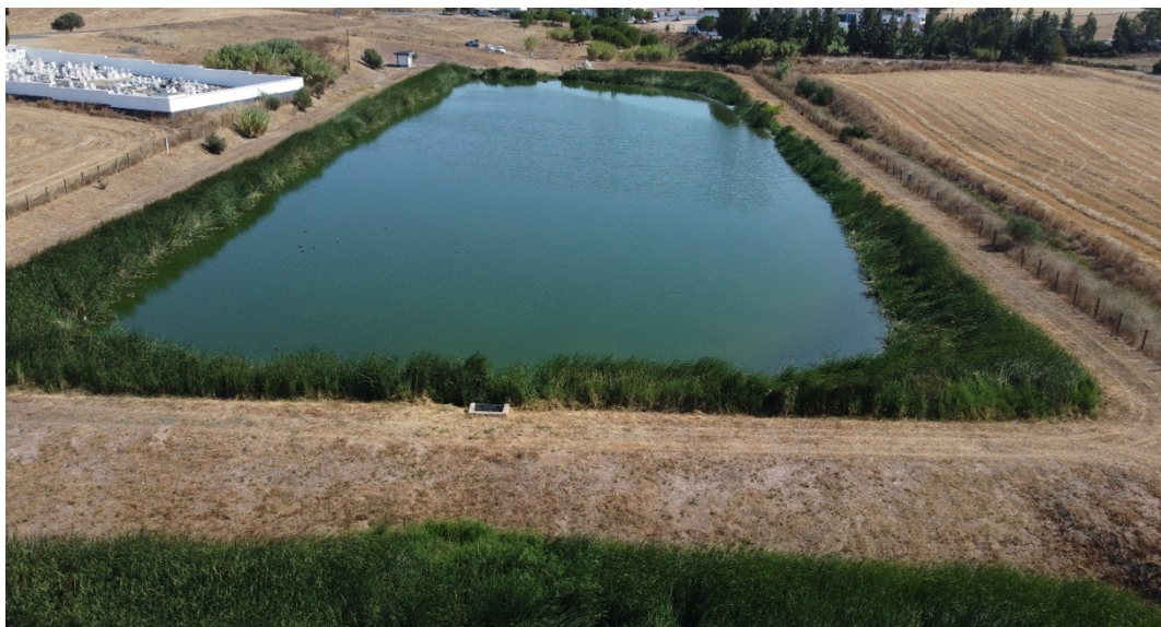
Figura 15 - Vista geral da ETAR do Penedo Gordo Sul (Hidrofunção – Consultores de Engenharia, Lda).
