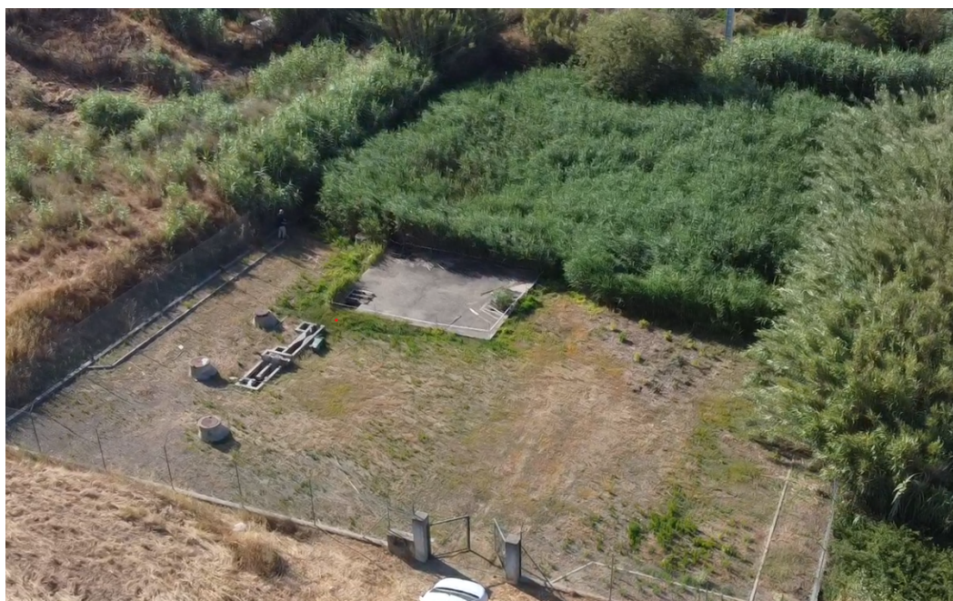
Figura 11 - Vista Geral da ETAR de Lousal Sul (Hidrofunção – Consultores de Engenharia, Lda).
