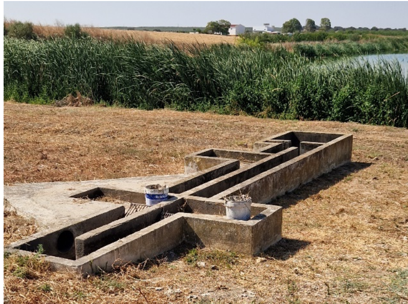
Figura 16 - Obra de Entrada da ETAR do Penedo Gordo Sul (Hidrofunção – Consultores de Engenharia, Lda).
