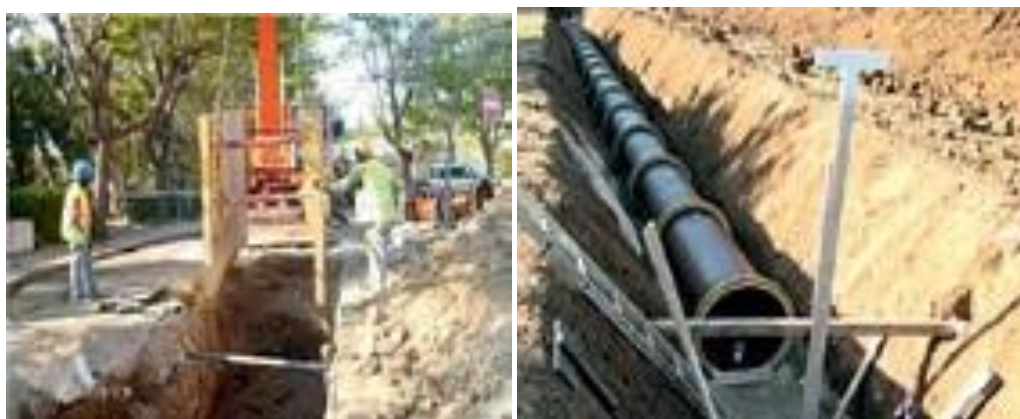
Figura 3. Reabilitação de condutas com abertura de vala.
