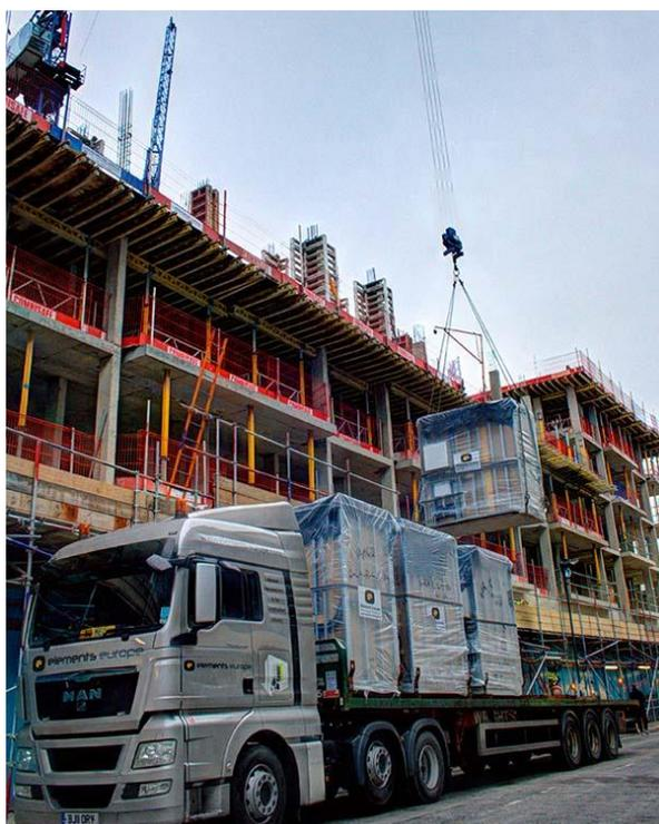
Figura 30 - Chegada dos módulos pré-fabricados à obra [48]
