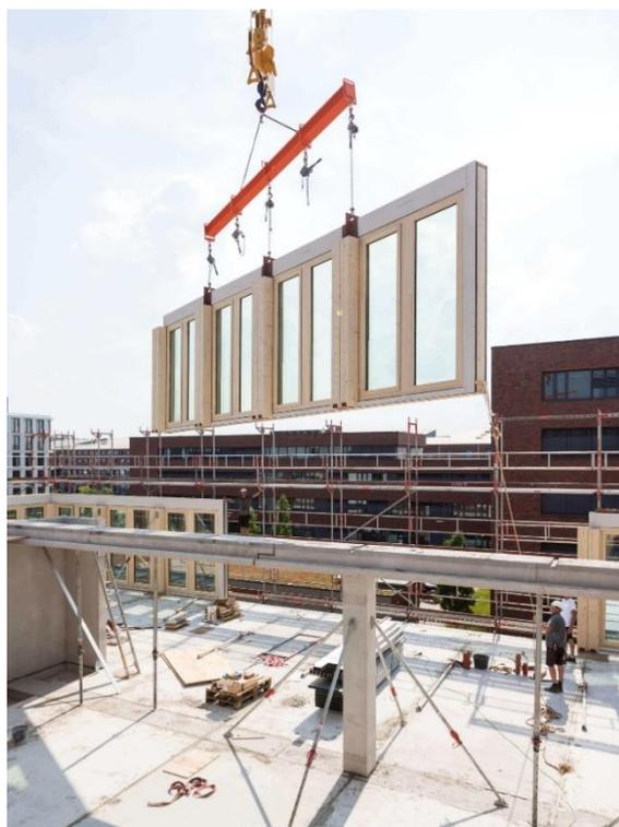
Figura 20 - Montagem de fachada pré-fabricada em sistema CREE [45]
