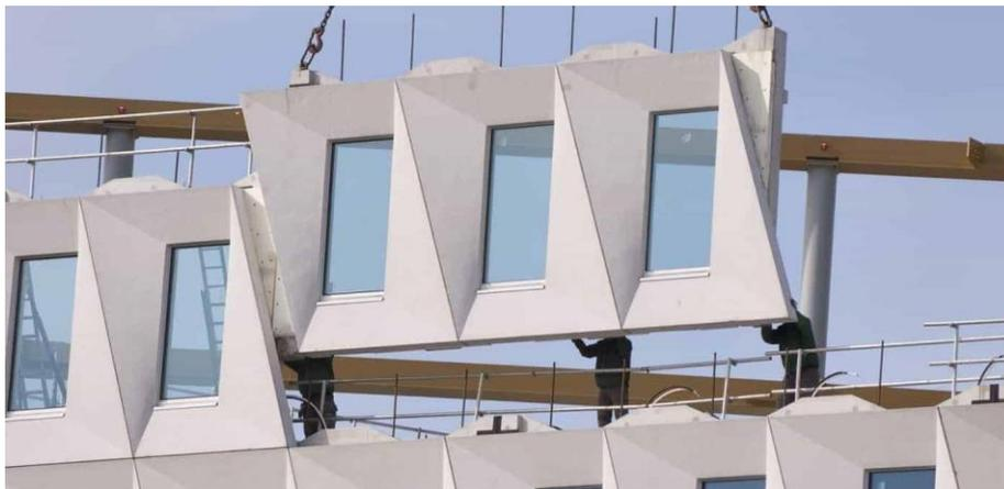
Figura 4 - Sistema de Fachada modular pré-fabricada [12]
