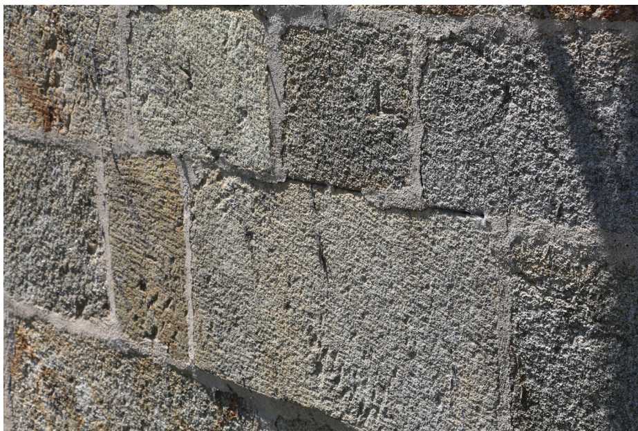
Fig. 5 – Siglas na parcela da residência correspondente à parte mais primitiva da casa a qual seria constituída por uma torre, um dos elementos definidores do seu carácter nobre. © João Marçal.
