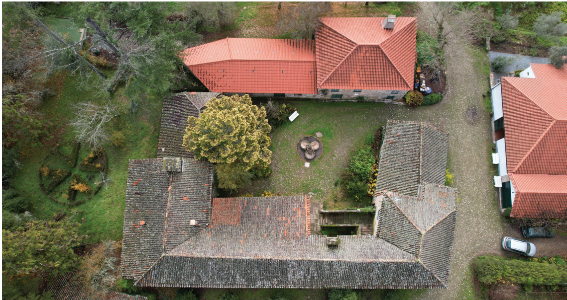
Fig. 3 – Fotografia aérea do conjunto edificado da Quinta da Comenda. No primeiro plano encontram-se as parcelas mais antigas e de função residencial. Em segundo plano vêm-se as construções de apoio à produção agrícola. © João Marçal.
