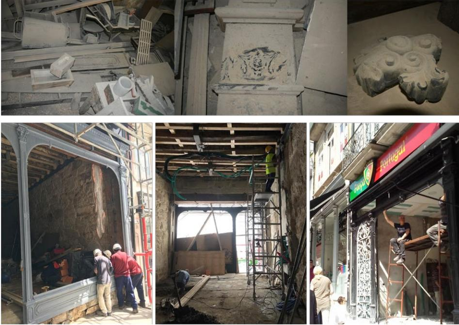
Figura 8. Diana Felícia. (superior): *Contramoldes de pilastra (esq.), de capitel (centro) e de florão (dir.)*. 2022. (inferior): Arquivo Companhia Industrial de Fundição. Processo de montagem da devanture da loja Força Portugal. 2022.
