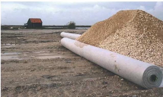
Figura 10. Colocação de geotêxtil de separação entre a fundação e a camada de sub-balastro (foto gentilmente cedida por Geosin, SA).
