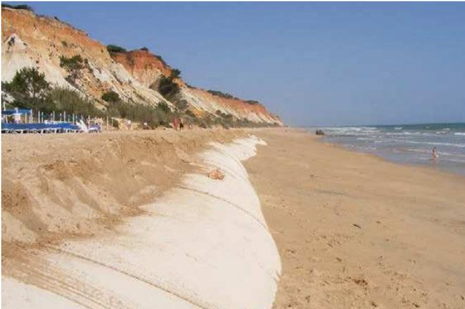
Figura 15. Geossintéticos na proteção costeira - Algarve, Portugal (foto gentilmente cedida por Geosin, SA)
