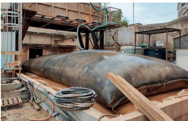
Figura 12. Geotubo® no tratamento de águas residuais produzidas na frente de obra - Lisboa, Portugal (foto gentilmente cedida por Geosin, SA).
