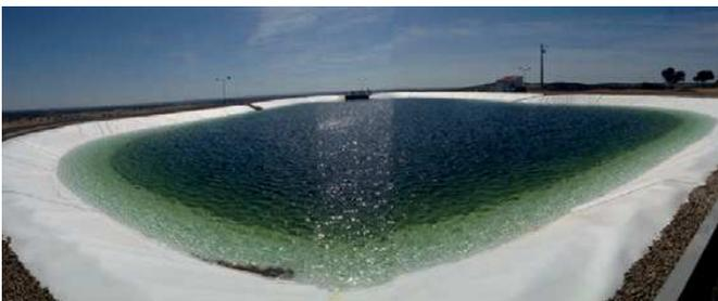
Figura 16. Geomembrana branca na criação de reservatórios artificiais (foto gentilmente cedida por BBF Tecnologias do Ambiente).
