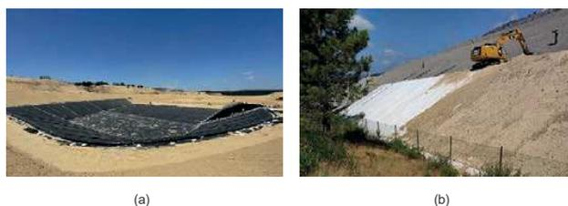
Figura 4. Utilização de geossintéticos como barreira: (a) no sistema de impermeabilização de aterro de resíduos perigosos - Chamusca; (b) no sistema de selagem dos taludes de aterro de resíduos - Penafiel (fotos gentilmente cedidas por BBF Tecnologias do Ambiente).
