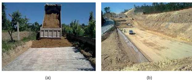
Figura 3. Utilização de geogrelhas de reforço: (a) aumento da capacidade de carga da camada de leito de estrada rural - Fundão; (b) aterro reforçado com geogrelhas em alternativa a muro em betão armado - Nogueira do Cravo (fotos gentilmente cedidas por BBF Tecnologias do Ambiente).
