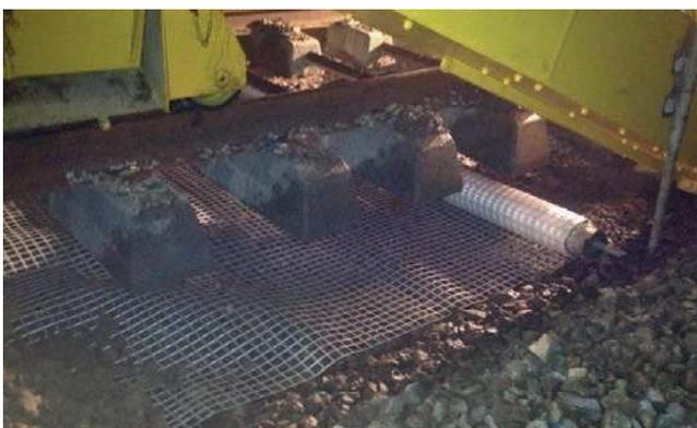
Figura 11. Colocação de geogrelha na base do balastro - Modernização da Linha do Norte, Portugal (foto gentilmente cedida por BBF Tecnologias do Ambiente).
