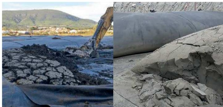
Figura 13. Geotubo® na desidratação de lamas e tratamento de águas de lavagem de areias (fotos gentilmente cedidas por Geosin, SA).
