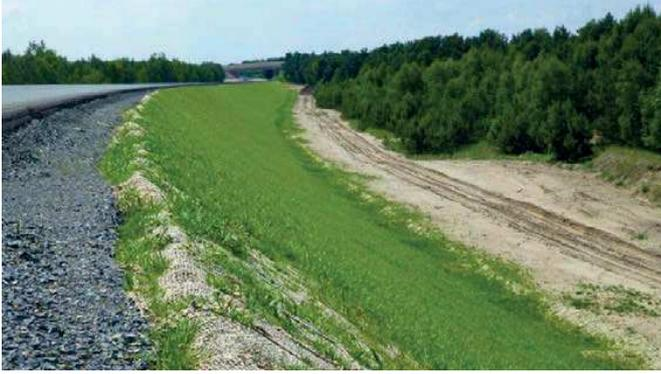
Figura 14. Sistema temporário de controlo de erosão produzido com fibras naturais de juta (foto gentilmente cedida por Naue).
