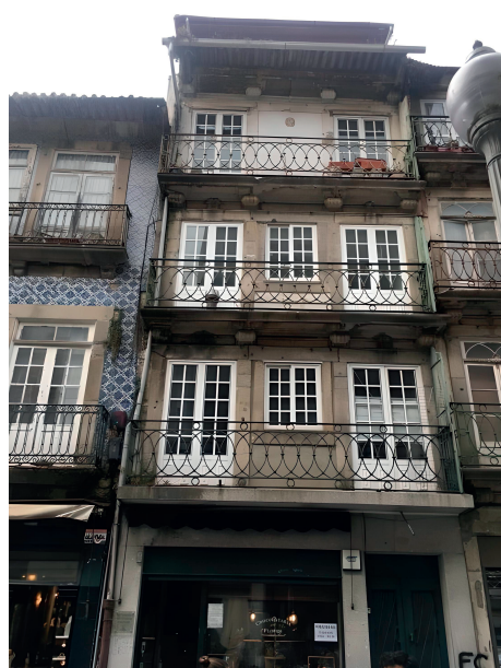
Fig. 9. Substituição dos caixilhos originais em madeira por novos em alumínio, com alteração do tipo de funcionamento. Fonte: Foto dos autores
