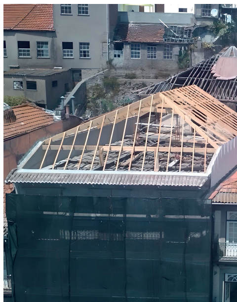
Fig. 6. Intervenção na cobertura da casa n.º 62, em 2014, seguindo as regras das boas práticas. Fonte: Foto dos autores
