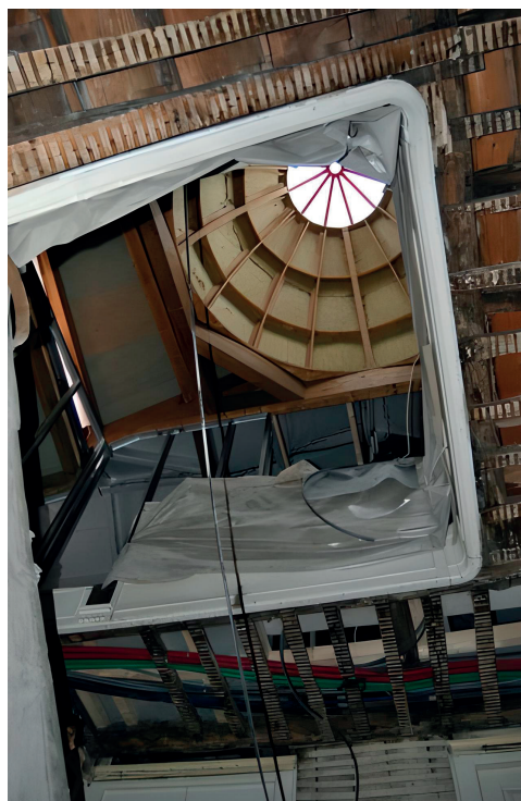
Fig. 11. Adaptação das redes ao existente e reconstrução da claraboia usando madeira, na Casa n.º 139 Fonte: Foto dos autores
