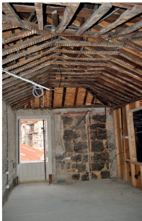
Fig. 12. Manutenção das estruturas existentes, em alvenaria e madeira, de um compartimento sob a cobertura da Casa n.º 139. Fonte: Foto dos autores
