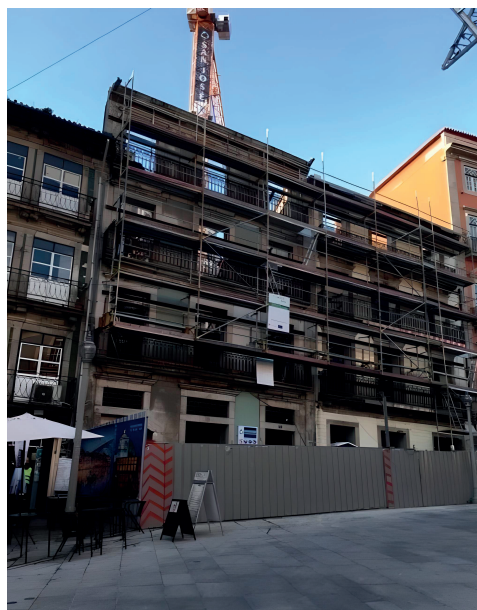
Fig. 7. Intervenção actual nas casas n.ºs 60-62 e n.ºs 63-65, baseada numa actuação fachadista. Fonte: Foto dos autores
