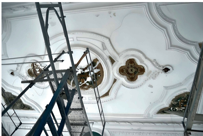
Fig. 10 Reparação das pinturas de um tecto da Casa n.º 139 Fonte: Foto dos autores
