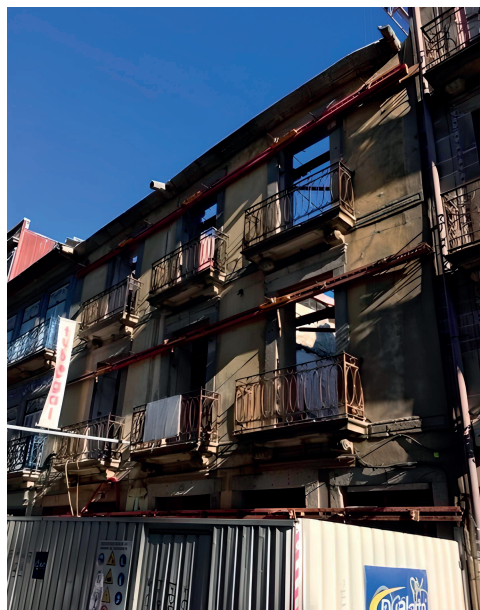
Fig. 4. Demolição integral de todo o interior da casa n.º 56-64, em 2017. Fonte: Foto dos autores
