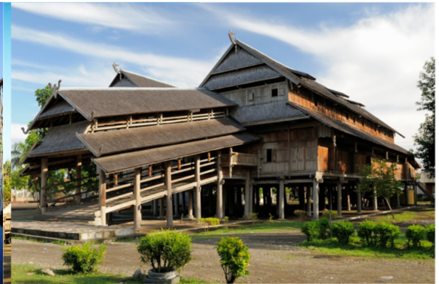
Suspensão, afastamento e ventilação. Casas típicas de clima quente húmido (Bahnar Rong, Vietnam)
