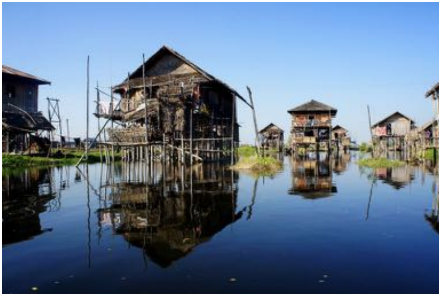
Suspensão, afastamento e ventilação. Casas típicas de clima quente húmido (Bahnar Rong, Vietnam)
