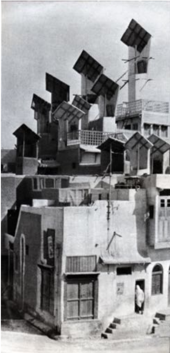
Massa térmica e ventilação. Casas típicas de clima quente-seco (Hyderabad, Sindh, Paquistão)
