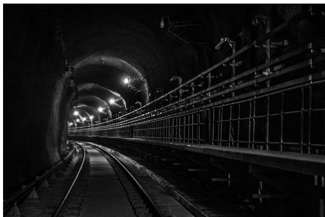
Figura 2 – Instalação da Via Permanente no túnel de ligação entre as Zonas Sul e Oeste.
