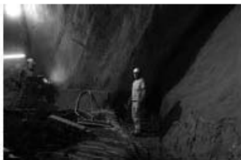
Figura 1 – Técnica de escavação Lasershell
