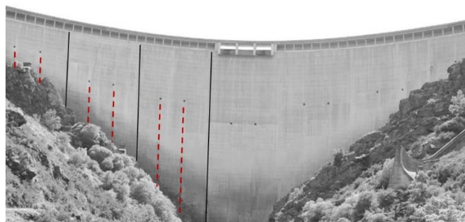
Figura 1. Juntas de contração na barragem de Las Portas
