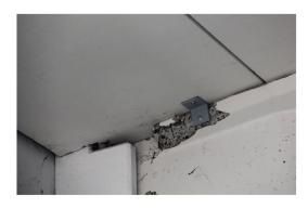
Dano na viga devido a ligação entre cobertura e viga
