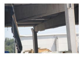
b) Colapso dos garfos no topo dos pilar devido a forças fora do plano
