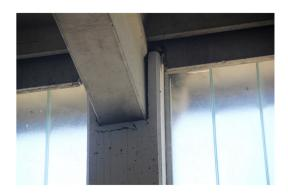
a) Perda de suporte da viga em relação ao pilar b) Ro Figura 3 – Danos verificados em vigas.
