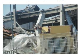
a) Formação de pilares curtos devido à interação com paredes de alvenaria de altura irregular
