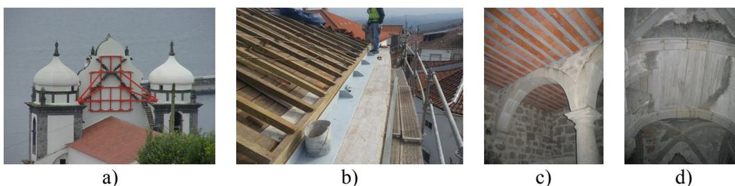
Figura 8. a) e b) Soluções reversíveis e compatíveis vs c) e d) Soluções não compatíveis e dificilmente reversíveis.
