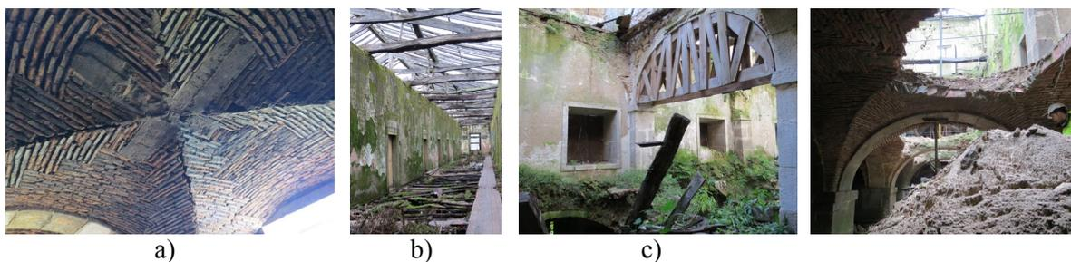
Figura 10. a) Abóbadas a preservar, b) estado do piso e cobertura c) e d) colapso de abóbadas.
