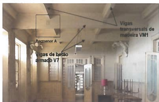
c) Sanatório de Valadares (Gaia) – Arquiteto Oliveira Ferreira – 1916. Laje em betão, vigas principais em betão e tijolo. Vigas secundárias fingidas em madeira.
