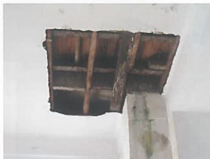
b) Pensão Monumental (Porto) – Arquiteto Michelangelo Soà – 1923. Pilares e vigas em betão armado, tetos e pavimento em madeira.
