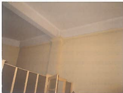
b) Pensão Monumental (Porto) – Arquiteto Michelangelo Soà – 1923. Pilares e vigas em betão armado, tetos e pavimento em madeira.
