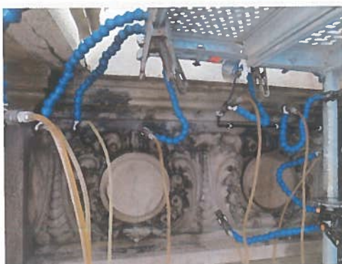
a) remoção de depósitos
