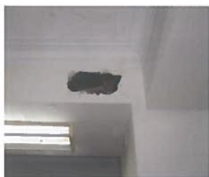
a) Edifício de comércio e habitação (Porto). Secção de viga fingida com aros de madeira fixos à viga e à laje e revestimento em estafe.
