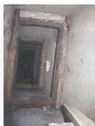
a) Edifício de comércio e habitação (Porto). Secção de viga fingida com aros de madeira fixos à viga e à laje e revestimento em estafe.
