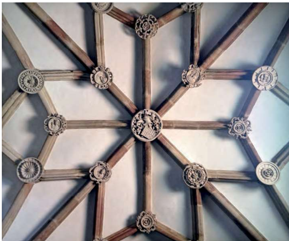
Fig. 15 – Abóbada da capela mor. 2017. JLM.
