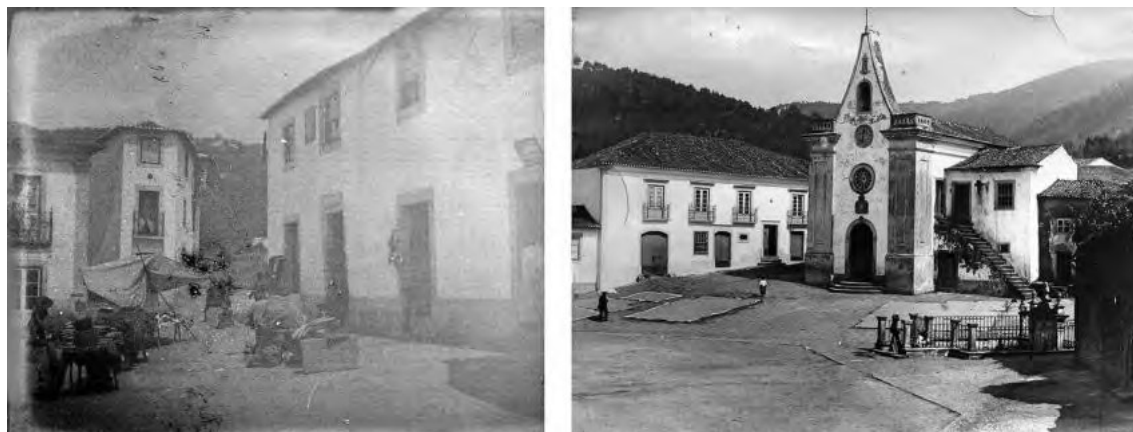
Fig. 8 – Praça – antigo hospital, lado nascente (à dir.). s/d. Col. particular JB. Largo do Pombal – casas Nogueira Ramos e Baeta da Veiga, igreja da Misericórdia e fonte, s/d. Col. particular.
