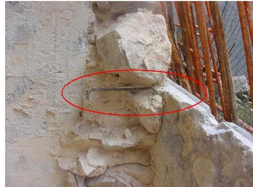
Figura 24: Pormenor do grampeamento do mármore à parede de alvenaria (2003).
