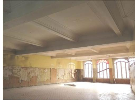
Figura 39: Teto de sala. Vigas avencer o vão entre a parede lateral meeira e a parede da caixa de escadas (2018).
