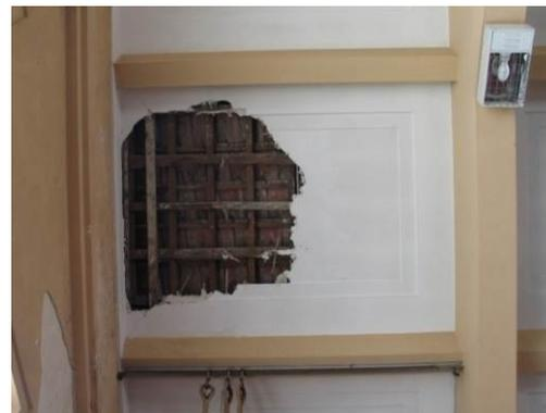
Figura 30: Estrutura de madeira do telhado do ginásio (2007).
