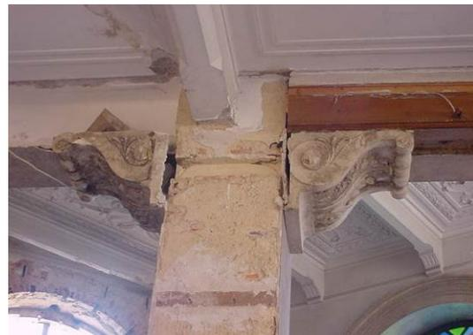
Figura 26: Pilares e vigas de betão com falsas mísulas (2003).
