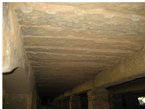
Figura 15: Estrutura em granito em zona sobrelevada (2011).
