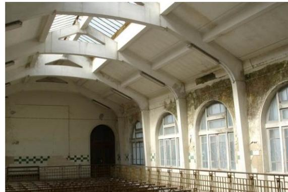
Figura 28: Estrutura de betão armado do edifício da piscina (2007).
