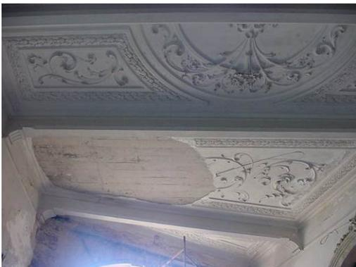
Figura 25: Estuques aplicados diretamente sobre lajes e vigas de betão armado (2003).
