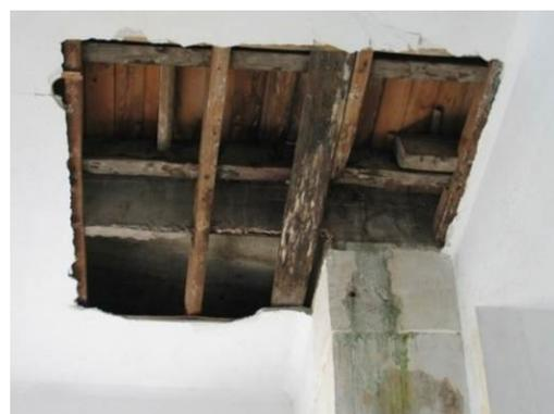
Figura 12: Estrutura dos pisos superiores da Pensão Monumental. Pilares e vigas de betão armado e pavimento e tetos em madeira (2004)
