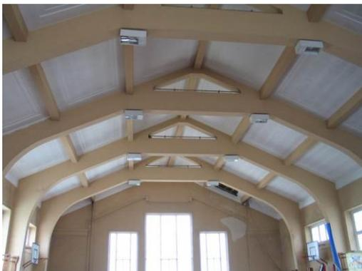
Figura 29: Ginásio com pórticos de betão armado e estrutura longitudinal em madeira (2007).
