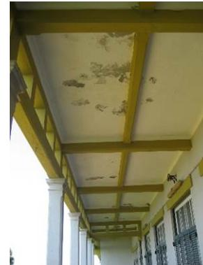
Figura 16: Laje de varanda em betão armado com vigas Vierendeel (2011).
