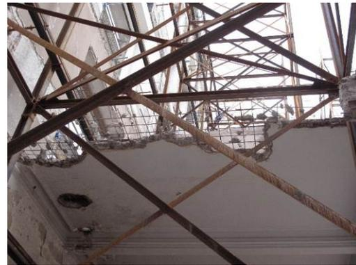
Figura 8: Demolição de laje maciça (2018).
