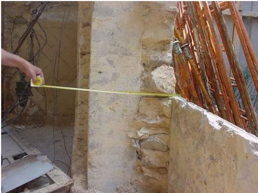
Figura 23: Estratigrafia de parede de zona posterior (2003).
