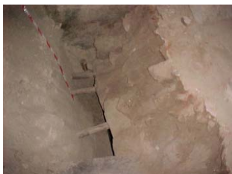
Figura 18 – Zona de inserção da estrutura metálica
