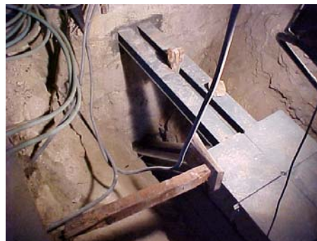
Figura 21 – Base para apoio de P_1
