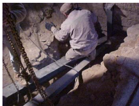
Figura 19 – Colocação da 1ª estrutura metálica
