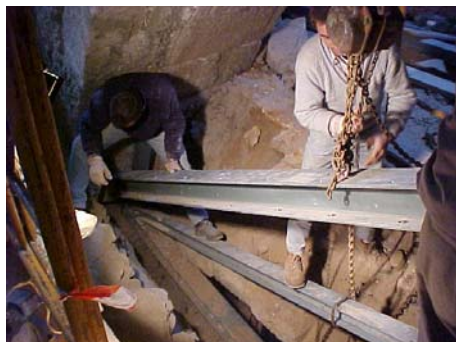
Figura 20 – Colocação da 2ª estrutura metálica
