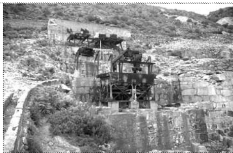
Fig. 7 - Regoufe. Ruínas da lavaría
