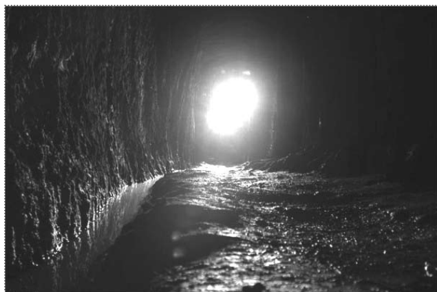
Figura 4 – Galeria com canal (num patamar superior) que conduzia a água para a galeria “G1” (foto Lúcia Baptista)
