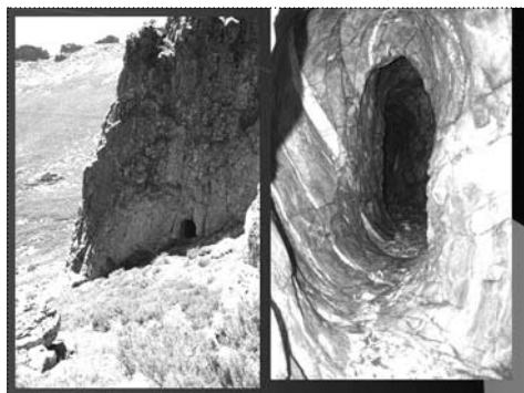
DIAPOSITIVA 43: - Túnel del canal TN-1 en el sector de Cambitos para pasar la cuarcita de Peña Cetrera
