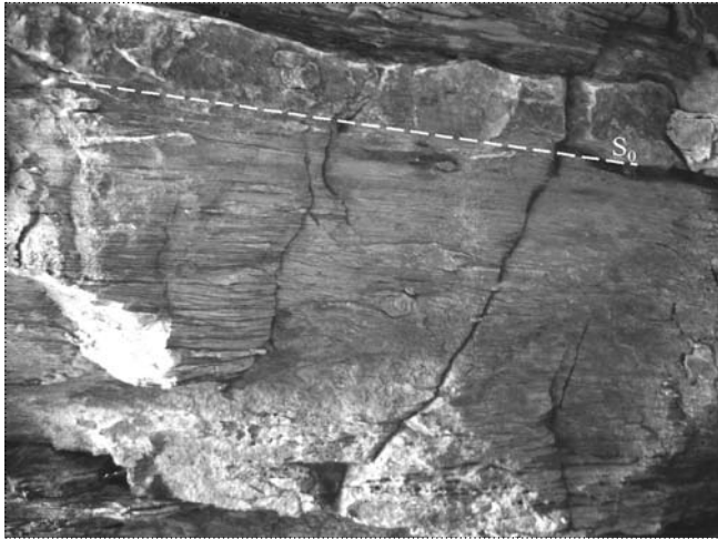
Figura 4 – Zona de cisalhamento com silicificação associada em níveis de filitos, quartzofilitos e quartzitos da Unidade de Curros (UC), sendo visível a estratificação ( S_0 ) (tecto da galeria Cardoso Pinto, no extremo SE da Corta de Ribeirinha).
