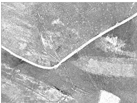
DIAPOSITIVA 36: - Vista aérea del acueducto del Portillo de Arriba y el soporte de canal
