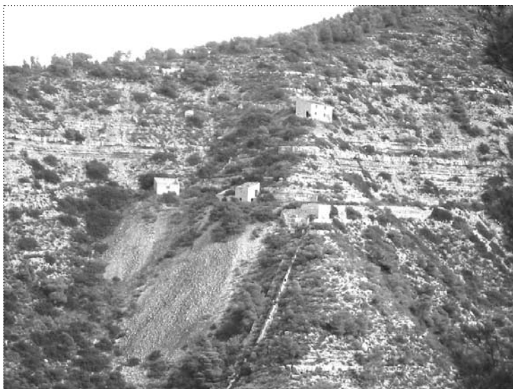
Aspecto de las instalaciones externas por encima del malacate
