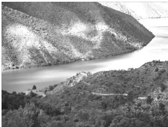
Un aspecto parcial de este tramo de la plataforma del ferrocarril (tramo 6) Al final del tramo se ve el tercer malacate, por encima del Ebro
