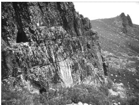
DIAPOSITIVA 40: - Túnel perforado en cuarcita para dar paso a un acueducto (izquierda) y labores superficiales sobre filones de cuarzo
