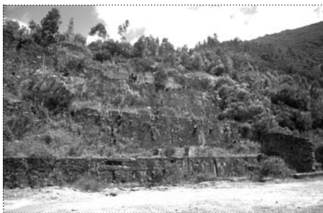
Fig. 10 - Rio de Frades. Ruínas da lavaría
