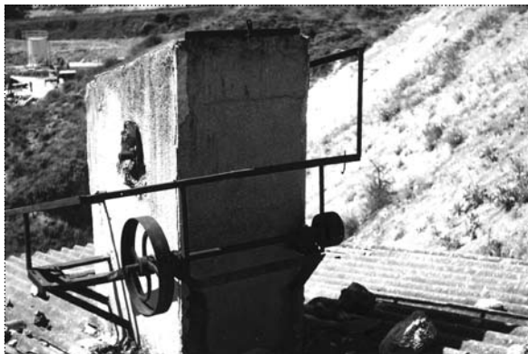
Fig. 9 - Detalle de la chimenea
