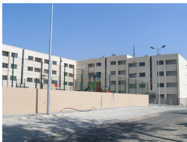
Fig. 27 - Fachada do edifício
