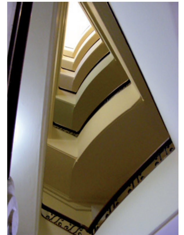
[445] - 'Fiação' building. (LIMA, 2013)
