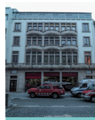
Building 'Bombeiros Voluntários' Rodrigues Sampaio Street 83-153 1946
