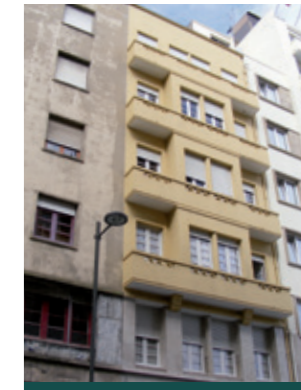
Building 'Pereira de Carvalho' Ramalho Ortigão Street 16-18 194-
