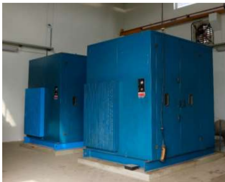
Figura 22: Sobreprensor de êmbolos rotativos.
