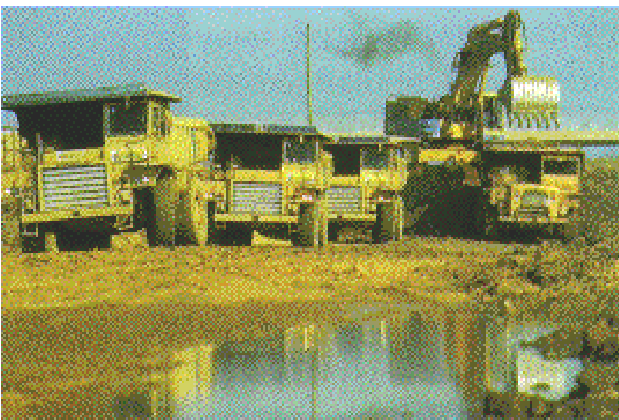
Extracção frontal (pá escavadora)
