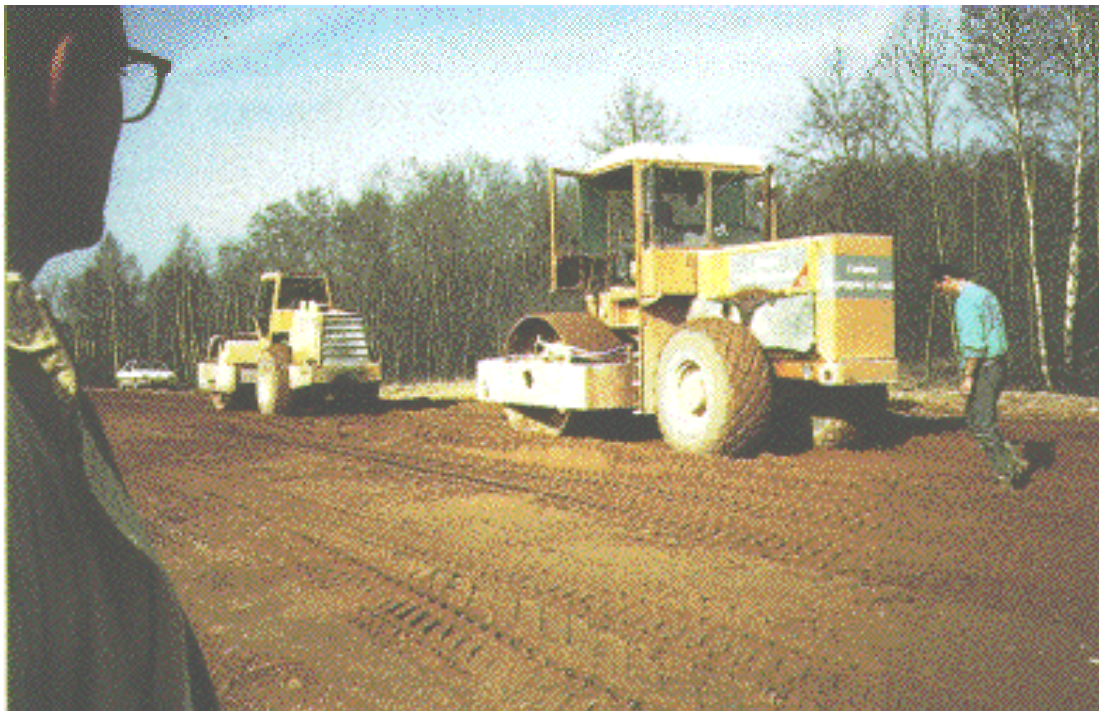
Compactador vibrante monocilíndrico liso (Vm4)
