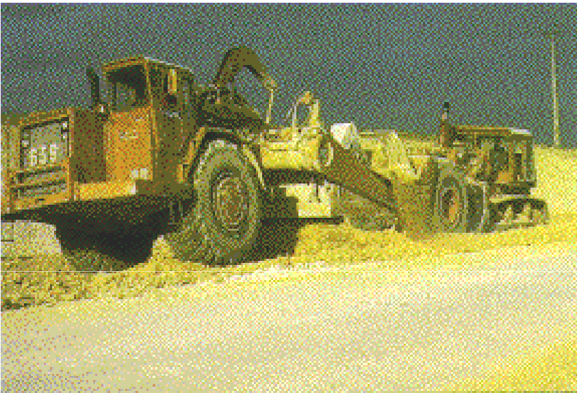
Extracção em camadas (moto-scraper)
