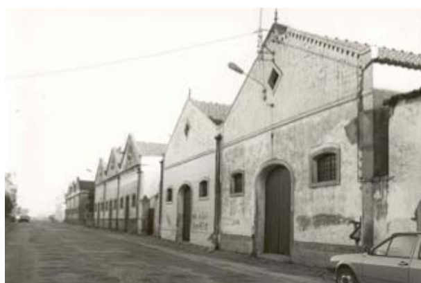
Figura 3 – Antiga Fábrica de Moagem de Cereais e Descasque de Arroz, Fachada principal. Fonte: CAC, 2014.
