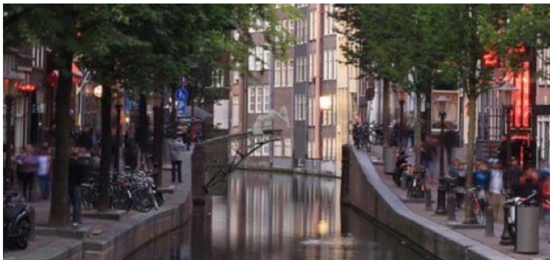
Figuras 14 e 15 - Ponte produzida pela empresa MX3D em Amsterdã, 2015. Fonte: MX3D Bridge (s/d.)
