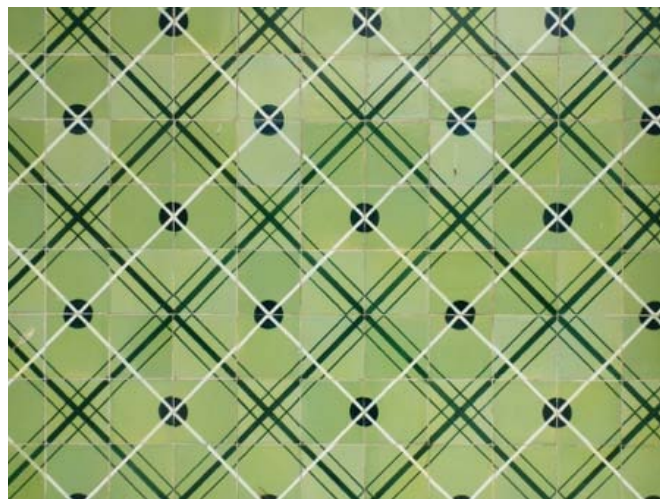
Figura 27 - Revestimento azulejar padronado, autoria de "Ant. Duarte".
