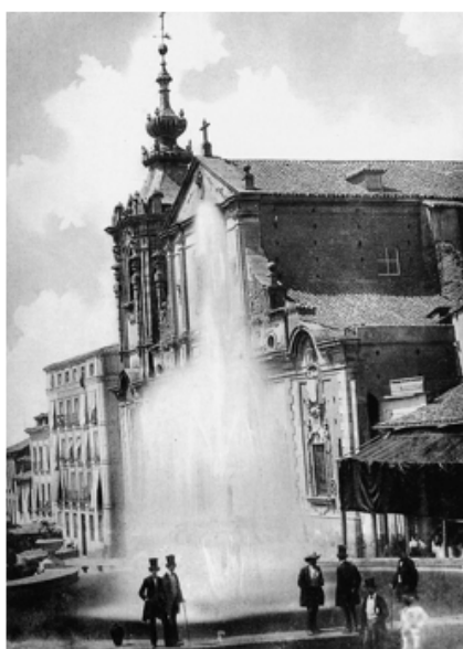
Figura 2. Obras para un sifón para el canal de Isabel II, 1851-58 (imagen Wikipedia, consultada 10-11-2016)
