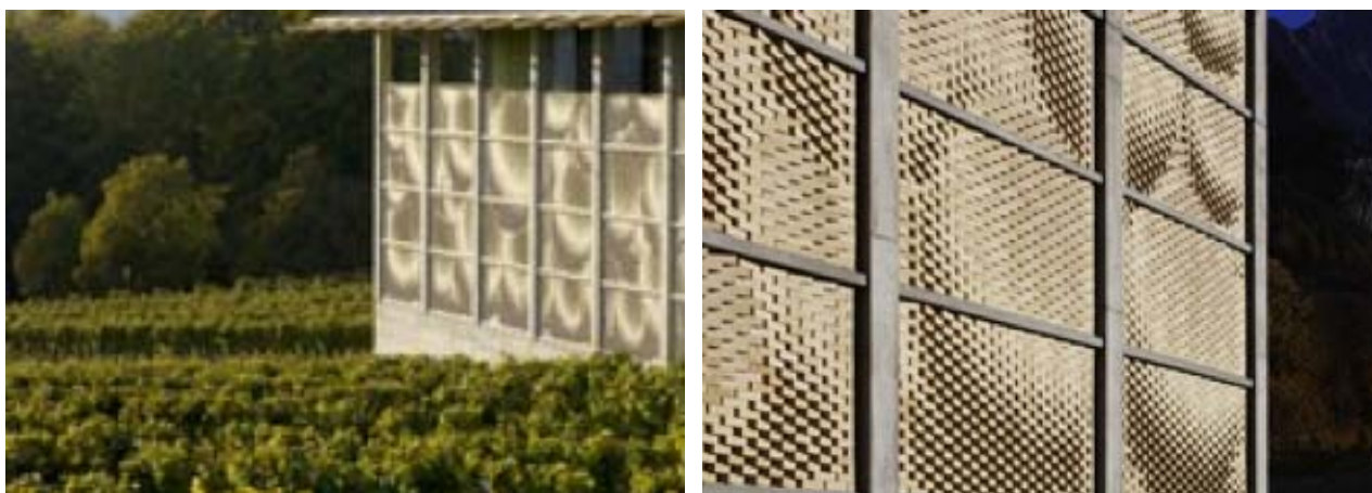
Figuras 5 e 6 - Edifício de serviços na adega Gantenbein, em Flasch, Suíça, 2006.
