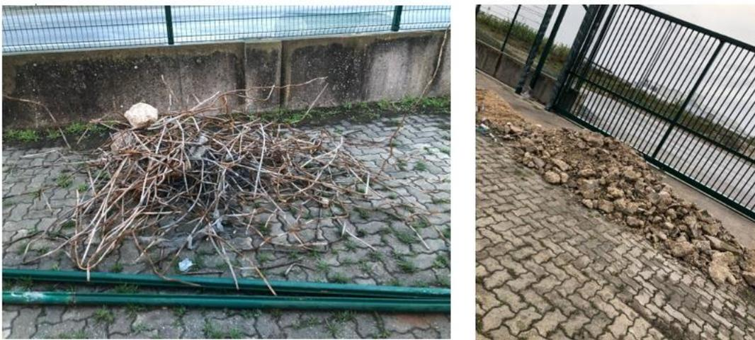
Figura 25: Aço e inerte originados da demolição do muro de betão armado, devidamente separados.
