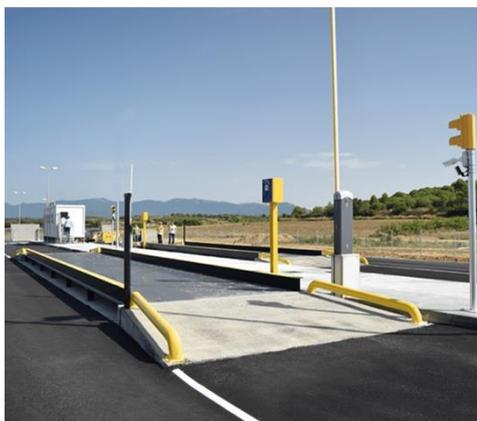
Figura 8: Exemplo de uma balança industrial aplicável ao processo em estudo<sup>4</sup>.
