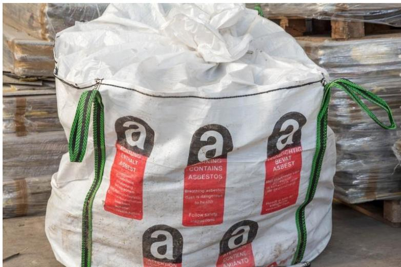
Figura 3: Armazenamento preliminar de resíduos com Amianto na sua composição (LER 17 06)<sup>1</sup>.
