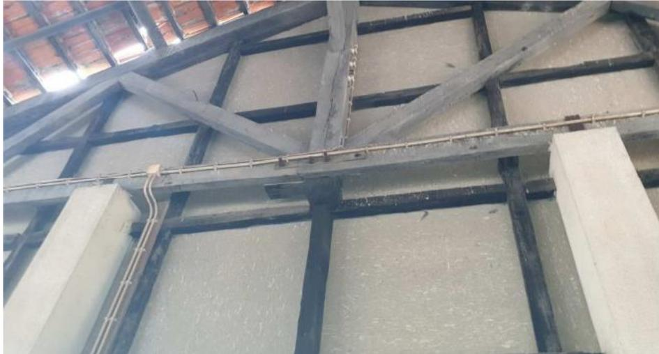
**Figura 40: Registo fotográfico da estrutura com amianto presente no Cais.**
