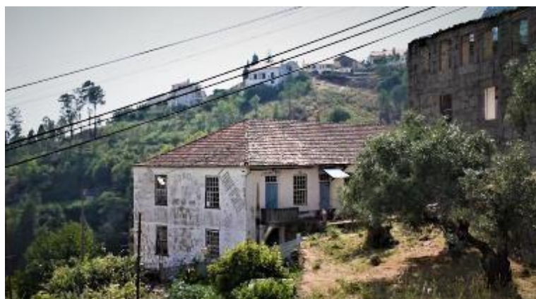
Figura 10: Ruínas de uma antiga fábrica de lanifícios. Loriga, 2019. Fotografia de Anaïs Proença
