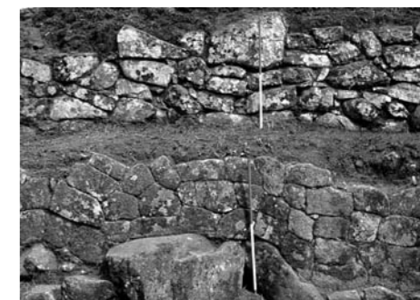
Fig. 8. Castro de Sabroso. Contraste de aparellos.
