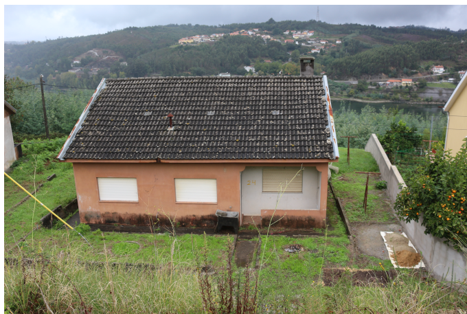
Figura 12 - Habitação A4. Fachada posterior. Créditos: Inês Pinho, 2021
