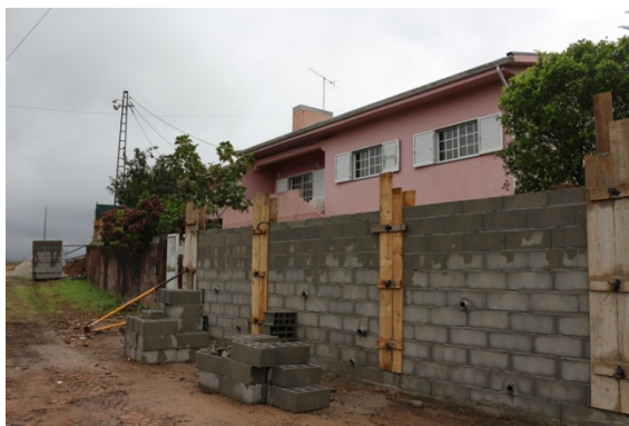
Figura 38 - Habitação em fase de manutenção e com indícios de intervenção arquitetónica. Créditos: Inês Pinho, 2021
