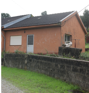
Figura 26 - Habitação E4. Fachada Principal. Créditos: Inês Pinho, 2021
