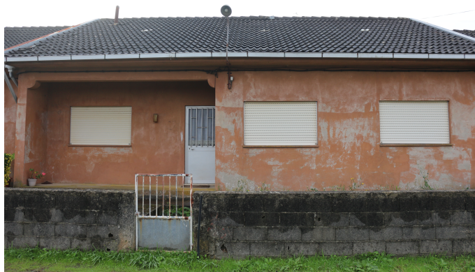
Figura 24 - Habitação E5. Fachada principal. Créditos: Inês Pinho, 2021
