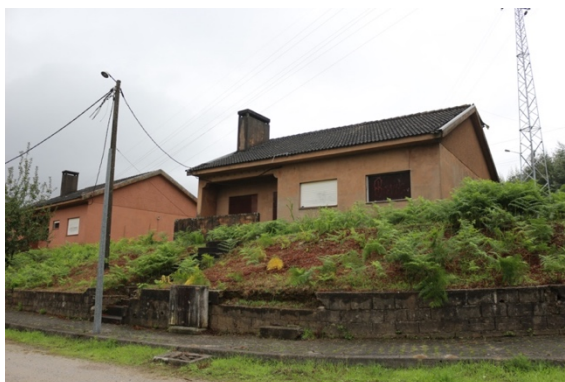
Figura 39 - Habitação demonstrativa do mau estado de conservação. Créditos: Inês Pinho, 2021
