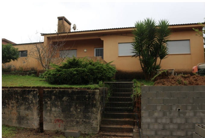
Figura 14 - Habitação B3. Fachada Principal. Créditos: Inês Pinho, 2021
