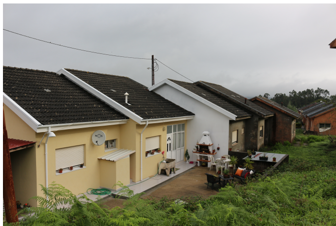
Figura 27 - Habitação E2. Fachada posterior. Créditos: Inês Pinho, 2021
