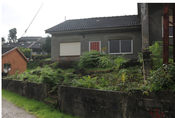
Figura 25 - Habitação E3. Fachada Principal. Créditos: Inês Pinho, 2021
