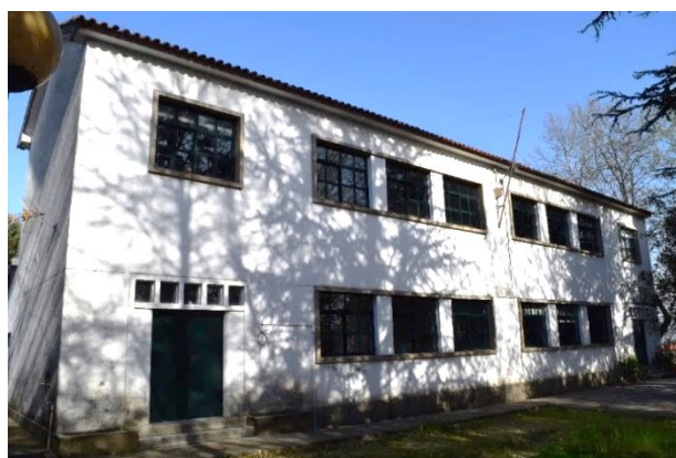
Figura 5.4 - Fachada principal da Escola Básica do 1.º Ciclo de Santiago de Candoso, orientada a Este (Nascente)
