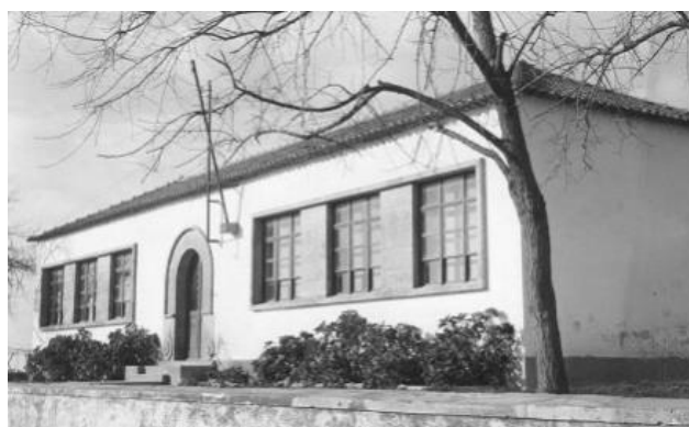
Figura 4.2 - Escola masculina de Terroso (São Salvador, Póvoa de Varzim); Edifício de 2 salas, simples. Tipo Douro Granito; Arquivo Direcção-Geral do Equipamento Escolar [64]
