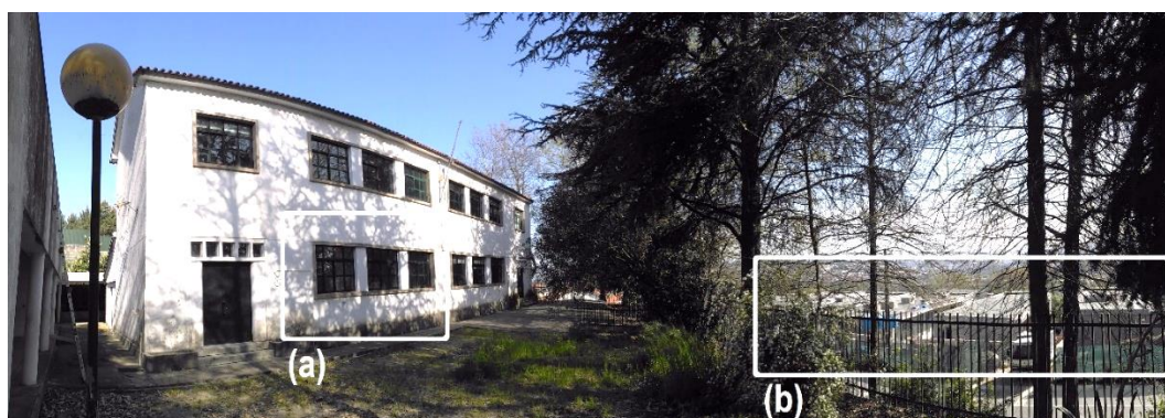
Figura 5.5 - Vista panorâmica da Escola Básica do 1.º Ciclo de Santiago de Candoso: (a) sala de aula disponibilizada; (b) construção a decorrer à frente da Escola Básica do 1.º Ciclo de Santiago de Candoso
