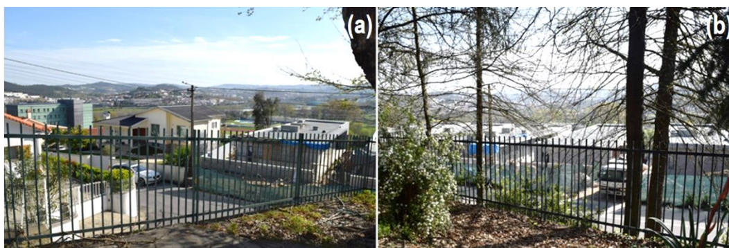
Figura 5.2 - Envoltório da Escola Básica do 1.º Ciclo de Santiago de Candoso: (a) edifícios habitacionais a Norte; (b) edifícios habitacionais a Este
