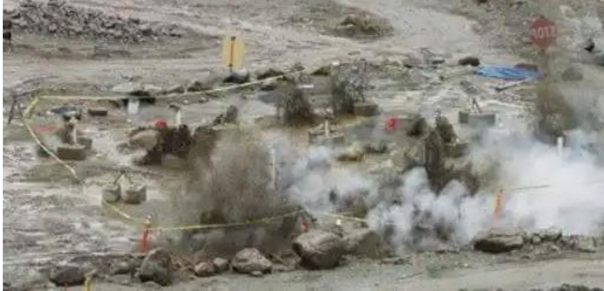
Fig. 27 – Processo de execução da compactação com explosivos (theconstructor.org, 2023)
