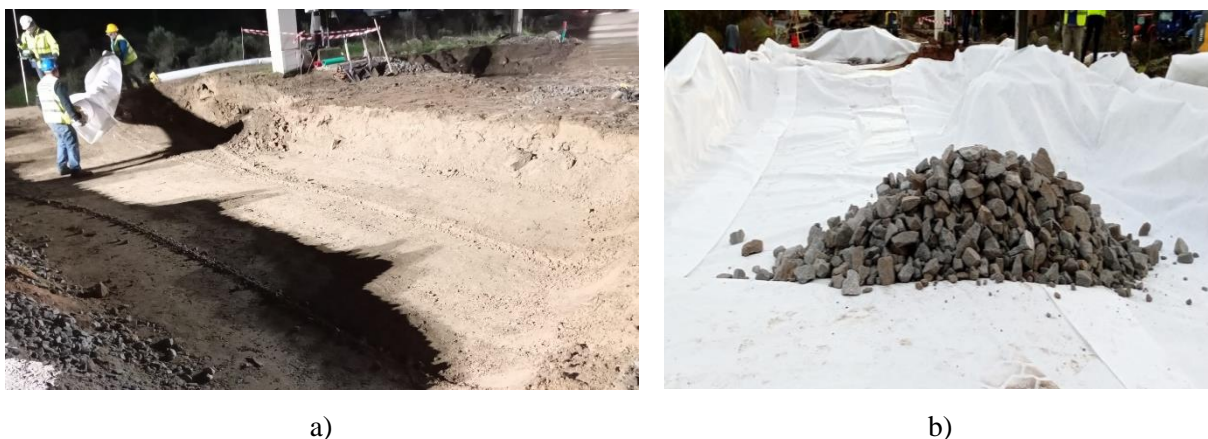
Fig. 35 – Processo de colocação do geotêxtil e do rachão: a) escavação até à cota necessária para colocação do geotêxtil; b) preenchimento da camada de rachão (Conduril, 2022)
