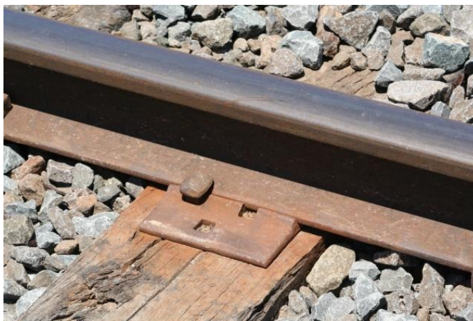
Fig. 4 - Elemento de fixação rígido (Rubinsztejn, 2011)
