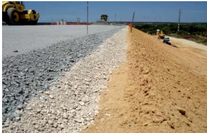
Fig. 13 - Camada de sub-balastro (Fortunato, 2014)
