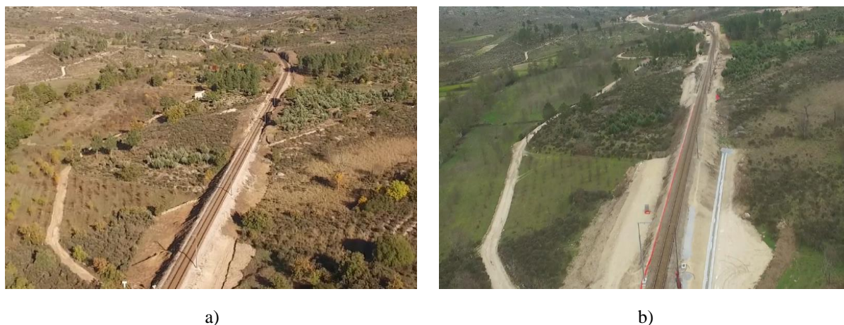
Fig. 38 – Criação de acessibilidades à obra: a) Terreno inicial antes da abertura do acesso b) Terreno acessível à passagem de equipamentos (Conduril, 2021)
