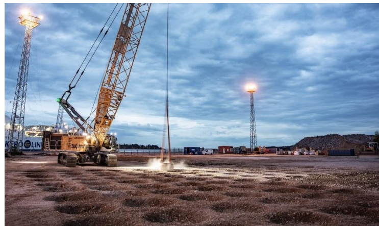
Fig. 25 – Processo de execução da compactação dinâmica (Liebherr, 2023)
