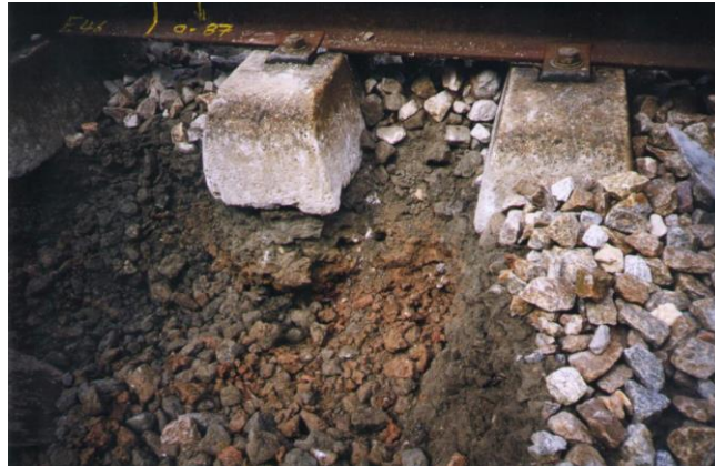
Fig. 17 – Balastro contaminado assente sobre uma plataforma de material fino (Fortunato, 2005)
