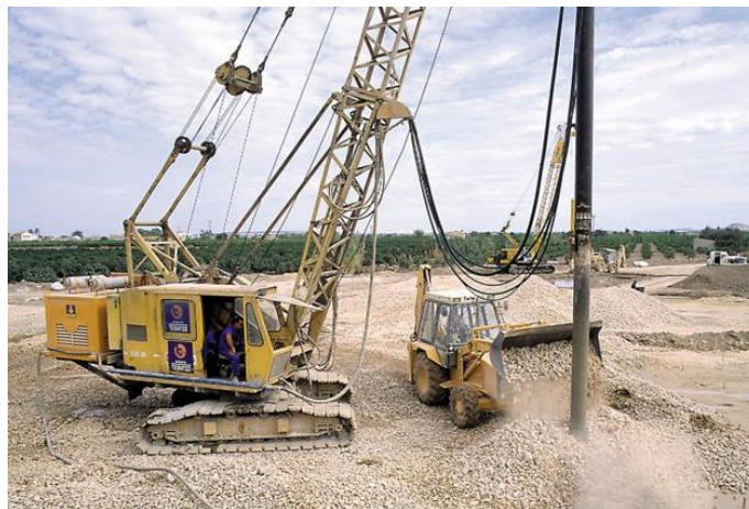
Fig. 30 – Execução de colunas de brita com recurso à vibrosubstituição (TERRATEST, 2023)
