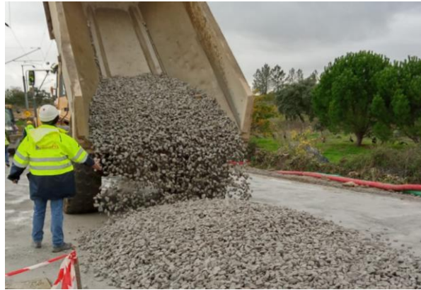
Fig. 37 – Colocação do novo balastro (Conduril, 2022)
