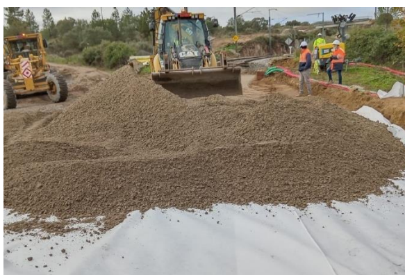
Fig. 36 – Execução da camada de coroamento (Conduril, 2022)
