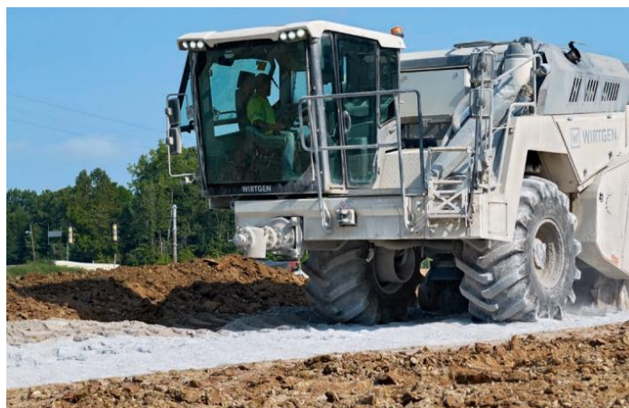
Fig. 20 – Mistura de cal no terreno (Wirtgen, 2023)
