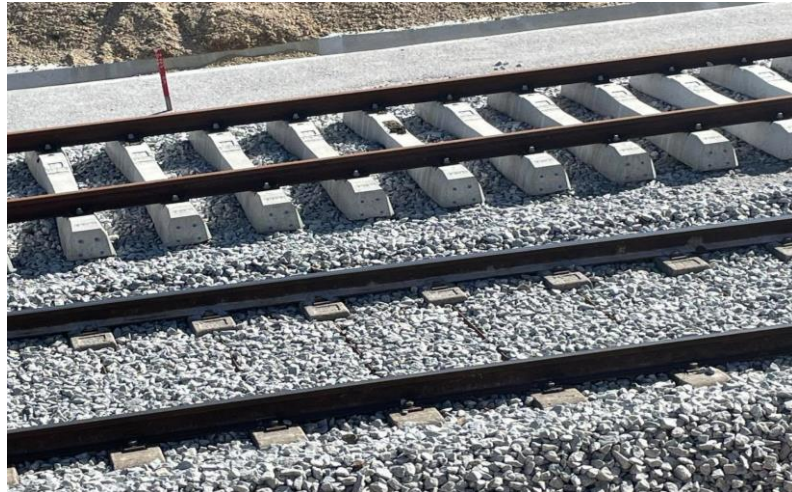
Fig. 7 - Via-férrea em travessas monobloco (em cima) e bi-bloco (em baixo) (Autora, 2023)
