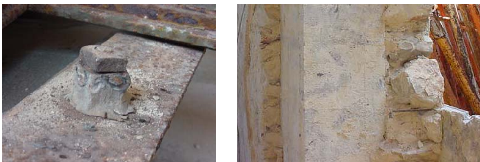
Figura 6. Pormenores: chumbo de envolvimento das peças metálicas a encastrar na alvenaria (esquerda), grampeamento dos elementos de revestimento às paredes (direita)
