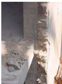
Figura 5. Paineis de enchimento de paredes em alvenaria de calcário
