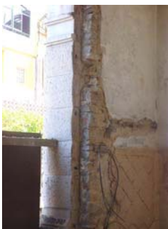
Figura 5. Paineis de enchimento de paredes em alvenaria de calcário
