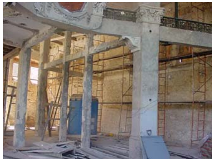
Figura 3. Estrutura de suporte em betão armado (esquerda) e fingidos de pedra em betão armado (direita)
