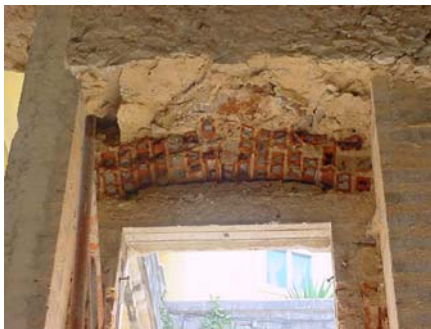
Figura 4. Arcos de alvenaria de tijolo sobre as padieiras das janelas e portas
