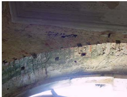
Figura 4. Arcos de alvenaria de tijolo sobre as padieiras das janelas e portas
