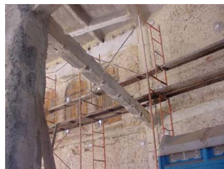
Figura 5. Paineis de enchimento de paredes em alvenaria de calcário
