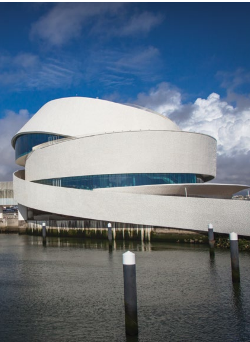
Vista do Terminal de Cruzeiros a partir do molhe poente. Foto. CPV / View of the Cruise Terminal from the west pier. Photo credits to CPV
