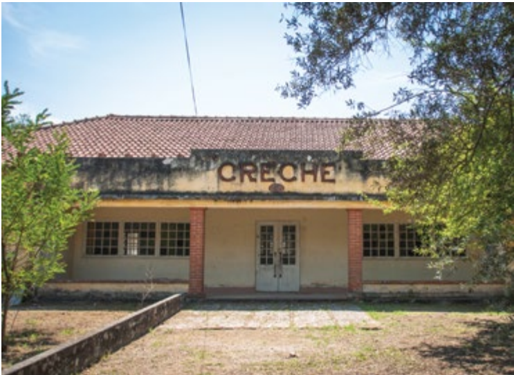
Edifício Creche da Fábrica de Porcelanas da Vista Alegre, construído em meados do século XX. Foto: CPV / Nursery house of Vista Alegre, build in the middle twentieth century, Photo credits CPV
