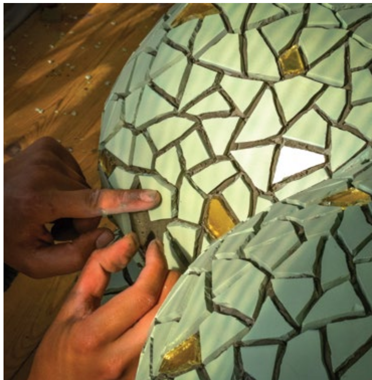
Processo de execução do revestimento com material cerâmico. Cortesia: Revigrés / Making-off coating with ceramic material. Courtesy of Revigrés
