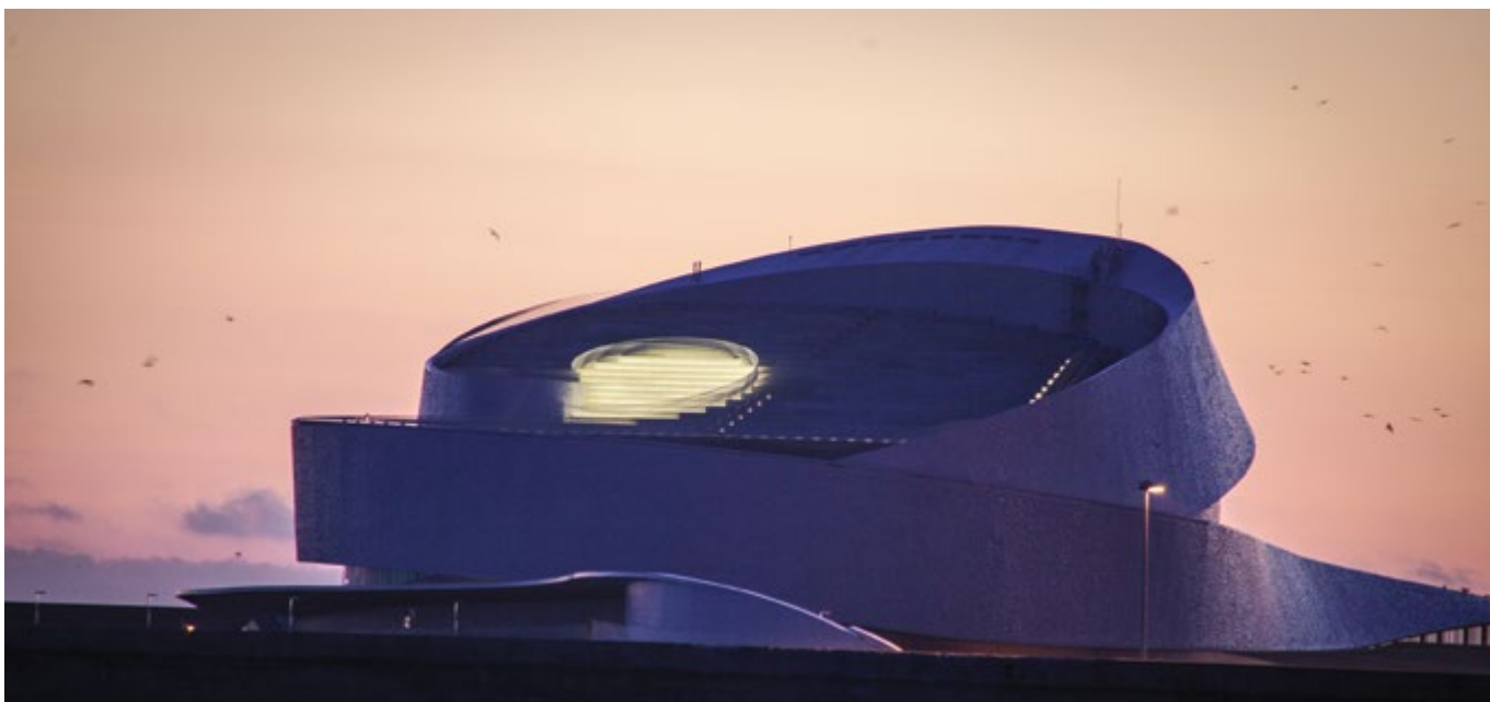
Fotografia do Terminal de Cruzeiros de Leixões, edifício inteiramente revestido com material cerâmico expressamente concebido, desenvolvido e testado para as exigentes condições de aplicação, quer do ponto da geometria das superfícies a revestir, quer do ambiente marinho a que está sujeito. Foto. CPV /View of Leixões Cruise Terminal, entirely covered with ceramic tiles, specifically designed developed and tested for demanding application circumstances, such as geometry of the surfaces to be coated and maritime conditions. Photo credits: CPV
