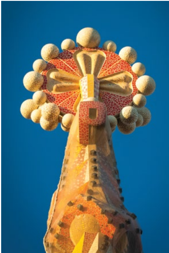
Revestimento do pináculo de uma das torres dos apóstolos com material cerâmico português. Cortesia: Revigrés / Lining of the pinnacle from one of the towers of the apostles done with portuguese ceramic material. Courtesy of Revigrés
