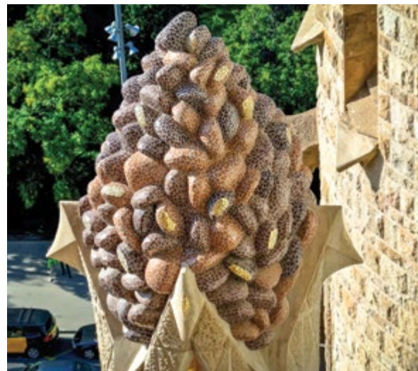
Material cerâmico em tons castanhos e dourados num dos pináculos inferiores. Cortesia: Revigrés / Ceramic material in brown and golden tones in one of the spires. Courtesy of Revigrés
