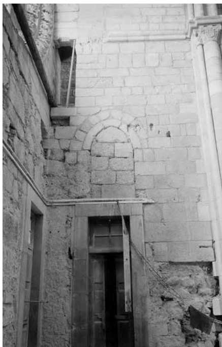
Vestígios de arco emparedado; interior de parede com arco emparedado; obras no interior do coro alto (s.d., Património Cultural, I.P.©, s.a. 298 ).
