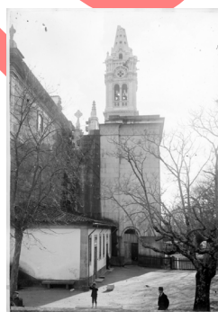
Figure 5: Outside view of the main chapel and transept. Coleção Fotográfica da Muralha - Repositório Casa da Memória.
