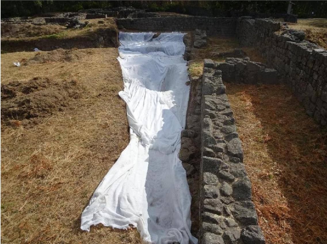
CAESAR\_LA\_9 - Vista geral após aplicação de manta geotêxtil, perspectiva O-E.
