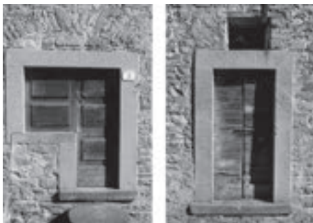
Fig. 17 - Murature con elementi di finitura in pietra arenaria
