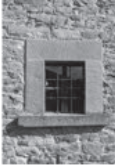
Fig. 18.1 - Murature con elementi di finitura in pietra arenaria
