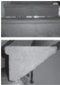
Fig. 18.3 - Scala a sbalzo in pietra arenaria
