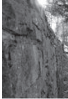
Fig. 7 - Muro di contenimento in pietra
